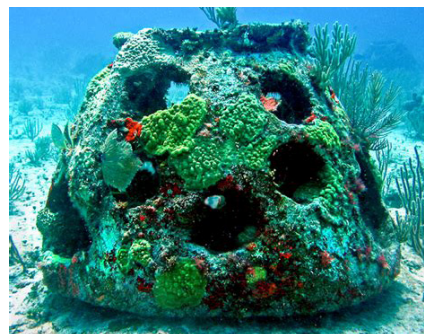
Barriere a campana ecocompatibili che sfruttano l'energia delle onde per la protezione delle coste.
