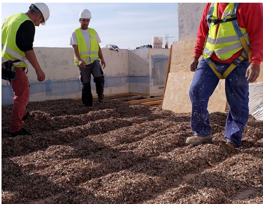
[Fig. 4.18] Posidonia spiaggiata come materiale isolante naturale..
