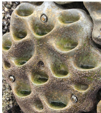
Il sistema a vite, aggiunge complessità alla struttura. Attrae organismi che filtrano gli inquinanti mantenendo l'acqua pulita.
