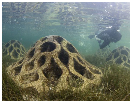
Moduli conici frangiflutti immersi per ridurre l'erosione costiera e ristabilire ecosistemi sani per la vita acquatica.
