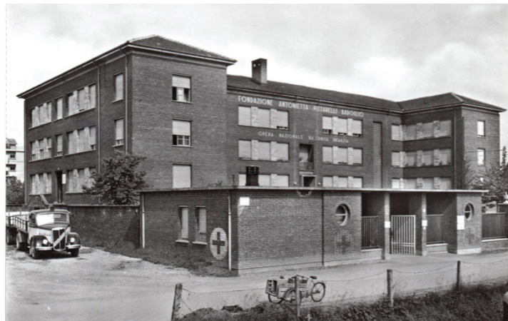
fig.17 Fotografia esterna dell'edificio Ex Maternità
