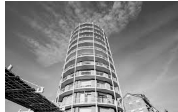
fig.18 Fotografia esterna della torre dell'acquedotto dopo l'intervento di rifunzionalizzazione
