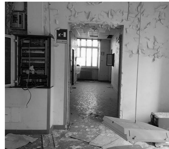
fig. 3 fotografia degli interni allo stato attuale
