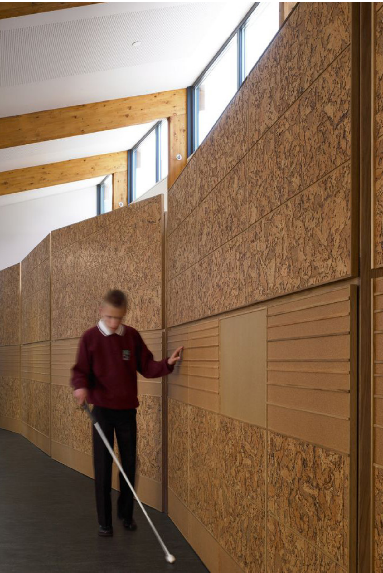
Fig. 13: percorso tattile per non vedenti, con superfici differenziate per facilitare l'orientamento e l'interazione con lo spazio
