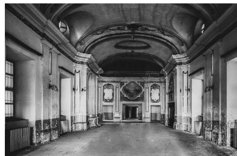
Foto degli spazi interni
