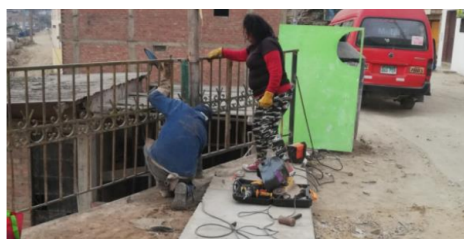
Mantenimiento de baranda existente Foto: Ocupa Tu Calle
