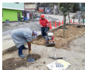
Nivelado de terreno Foto: Ocupa Tu Calle
