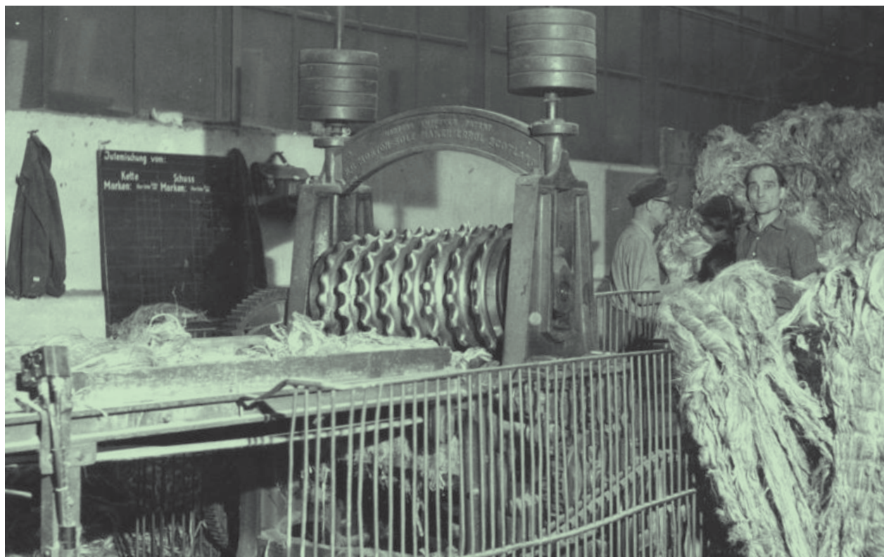
Fig. 28 - Macchinario per la stigliatura - Foto di Rolf Unterberg, 1953, Bundesarchiv
