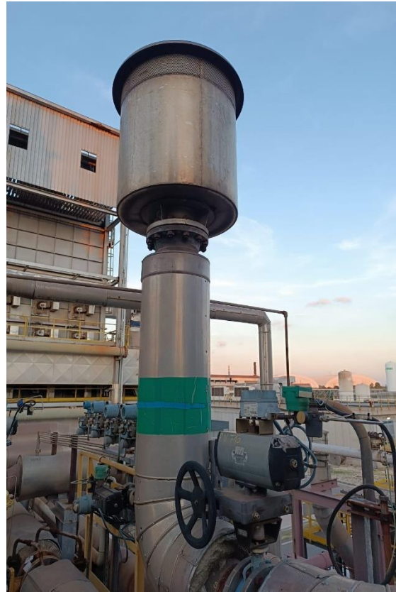
Fig. 4.1.2.1 Valvola IGV con sistema di regolazione (a sinistra); valvola BOV (a destra)
