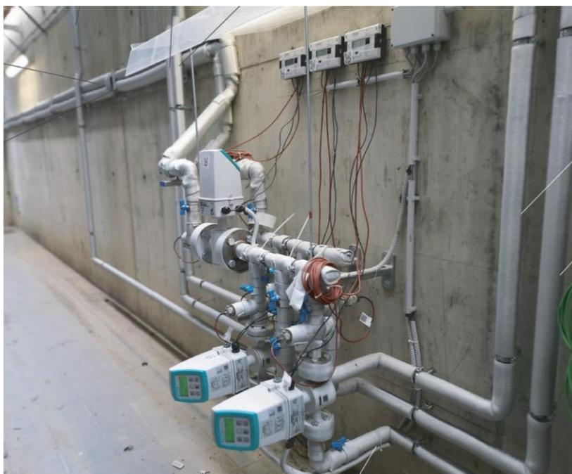
Figura 17 - Collettori circuito primario Geothermskin
