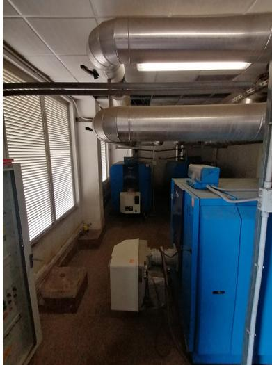
In copertura sono presenti sei pompe di calore, delle cui quattro riversano l'energia termica all'interno di un unico collettore, venendo poi distribuita nelle diverse sottocentrali. I gruppi termici sono in ottime condizioni, installati da qualche anno, ed hanno un'ottima efficienza, ma non possono sostenere le richieste termiche legate al riscaldamento, di tutta la struttura, quindi bisogna lavorare anche sulla generazione in centrale termica.
