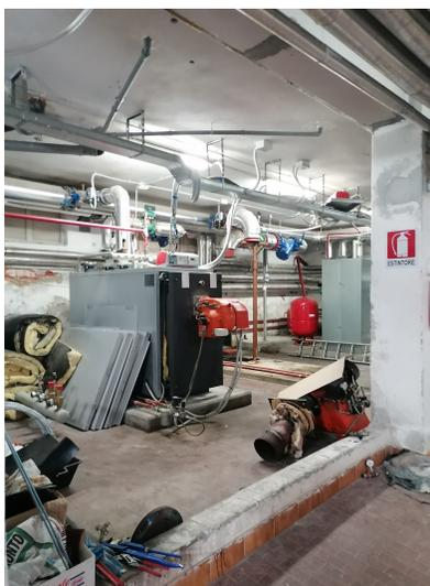
I gruppi termici destinati al raffrescamento sono sparsi per la struttura ed alimentano i sistemi di riciclo dell'aria che sono distribuiti nei controsoffitti dei vari piani. Solo alcune aree hanno gruppi termici dedicati in funzione delle ore di funzionamento e della destinazione d'uso, come le sale operatorie e le sale parto. Al piano terra, all'esterno, sono presenti le due pompe di calore principali di tutta la struttura.
