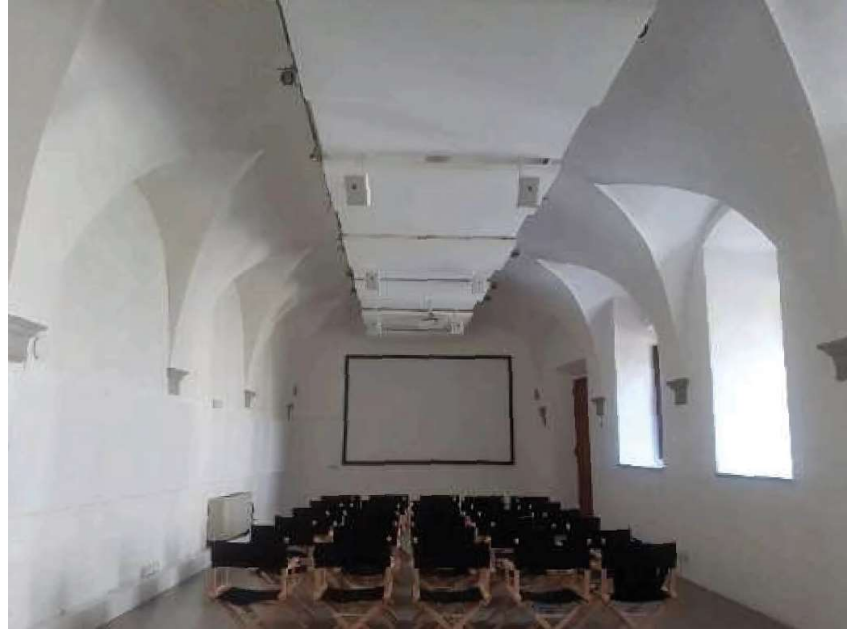
Fig. 3.1.1.4 Veduta interna della sala dopo l'intervento di correzione acustica
