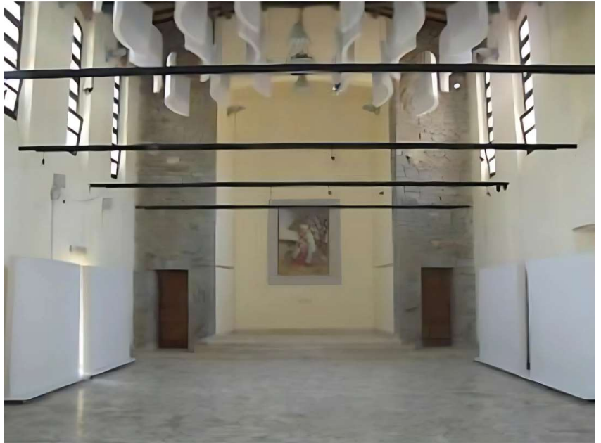
Fig. 2.1.2.9 Veduta interna della chiesa post intervento
