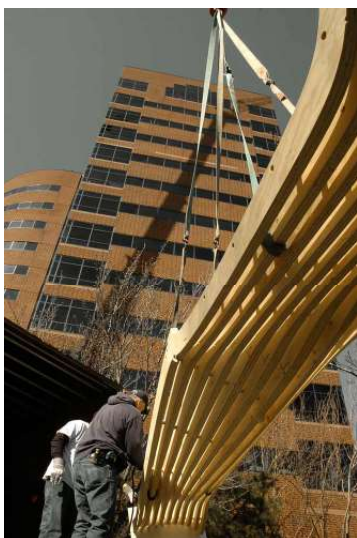
Fig. 0.5, 0.6, 0.7 One Main Office Renovation by dEEOi Architects, 2009. Cambridge, MA, USA. 0.5, immagine di cantiere. 0.6, disegno di progetto. 0.7, vista dell'interno. parametric-architecture.com
