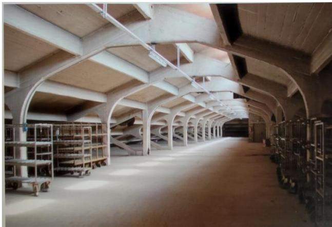
Figura 11: Manifattura Tabacchi di Firenze, copertura in cemento armato, ingg. Nervi & Nebbiosi. Foto Massimo Preite, 2010. *Le fabbriche del tabacco in Italia. Dalle manifatture al patrimonio*, Celid, Torino, 2012.
