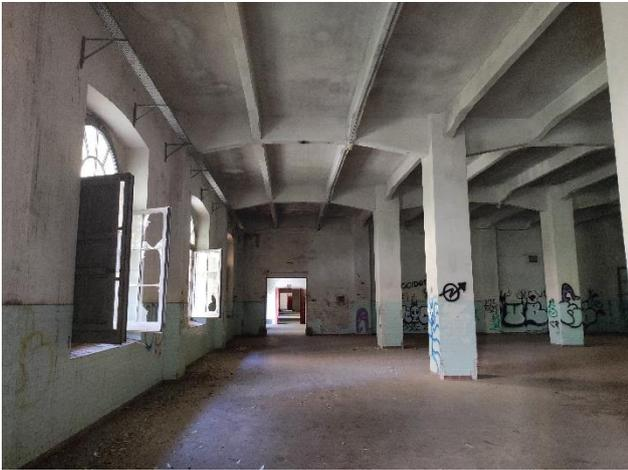
Figura 43: Atti vandalici mediante graffiti e danneggiamento alle varie aperture (finestre e porte). Fonte: *riproduzione personale mediante sopralluogo (settembre 2022)*
