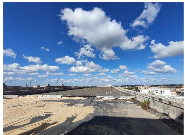
Figura 52: Guaina bituminosa impermeabilizzante usurata, disgiunta e mancante (vista dal tetto). Fonte: *riproduzione personale mediante sopralluogo (settembre 2022)*
