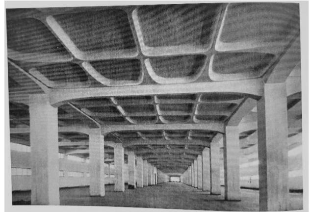
Figura 8: I solai del Magazzino "Ballette" della Manifattura Tabacchi di Bologna (Tavola XLII in P.L. Nervi, *Costruire Correttamente*) del Lanificio Gatti di Roma (Tavola XLV in P.L. Nervi, *Costruire Correttamente*). *La Manifattura Tabacchi a Bologna. Ricerche sull'architettura industriale contemporanea tra storia, tecnica e riuso*. Bononia University Press, 2019.
