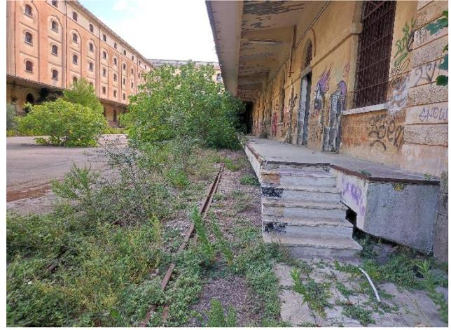
Figura 48: Presenza di vegetazione spontanea e atti vandalici sulla facciata della corte interna. Fonte: *riproduzione personale mediante sopralluogo (settembre 2022)*
