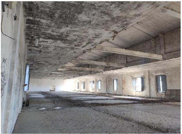
Figura 46: Presenza di alcuni effetti negativi dovuti al periodo di abbandono (umidità e finestre con deformazioni e alterazioni cromatiche). Fonte: *riproduzione personale mediante sopralluogo (settembre 2022)*
