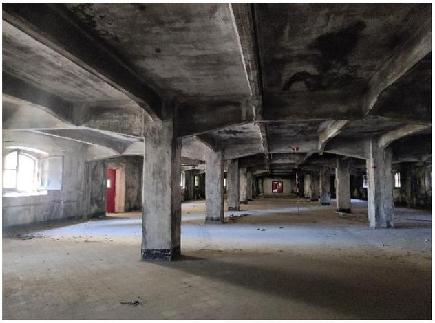
Figura 44: Presenza di alcuni effetti negativi dovuti al periodo di abbandono (fenomeno dell'umidità). Fonte: *riproduzione personale mediante sopralluogo (settembre 2022)*
