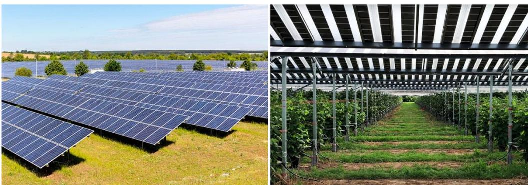
Figura 14 – Impianto fotovoltaico a terra vs. impianto agrivoltaico (fonte: Edilportale e Greenmove)
