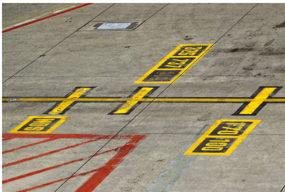
Segnaletica stradale orizzontale dell'area di manovra di un aeroporto
