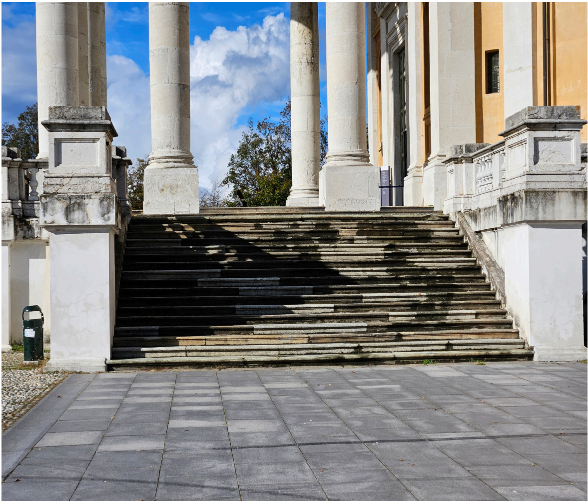
Figura 13: Una delle 3 rampe da 17 gradini che separano il piazzale dalla Basilica.
