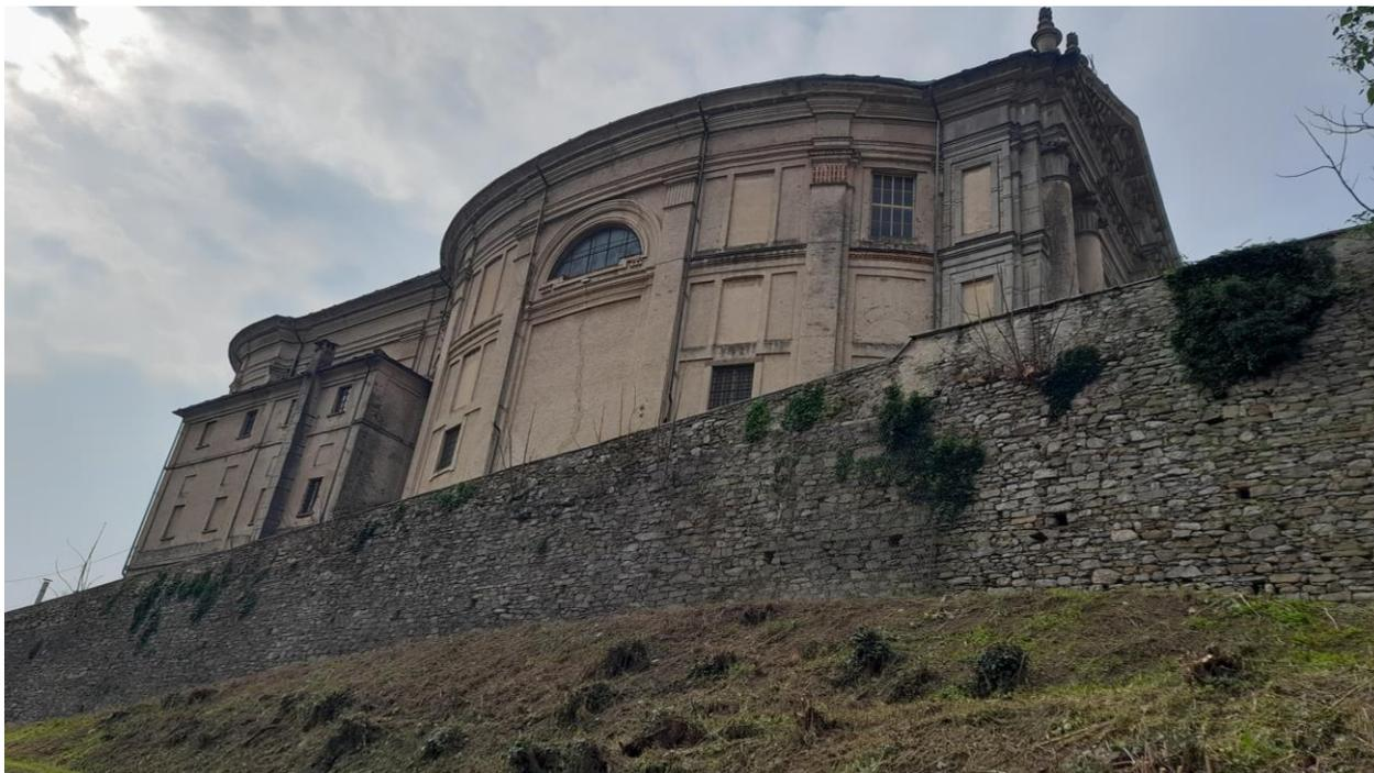
Figura 25 – Fianco Nord in cui si vede il raccordo tra la parte della facciata in pietra gneiss di Cumiana con il corpo curvilineo della chiesa. E raccordo del volume parallelepipedo (Cappella del Santissimo Sacramento) in corrispondenza del presbiterio.
