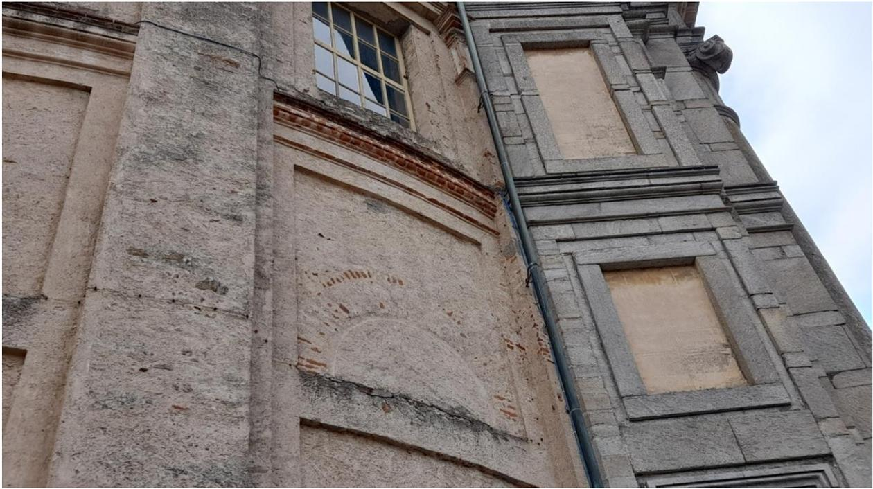
Figura 27 – Dettaglio raccordo tra il corpo curvilineo della chiesa e la parte rettilinea della facciata in cui si notano alcune parti scoperte dall'intonaco.
