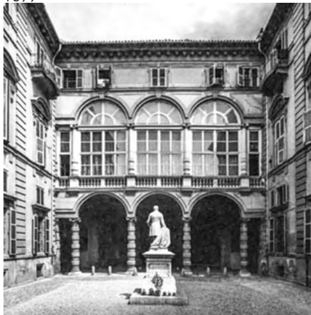
Palazzo Morozzo della Rocca, facciata verso il parco. 1916
