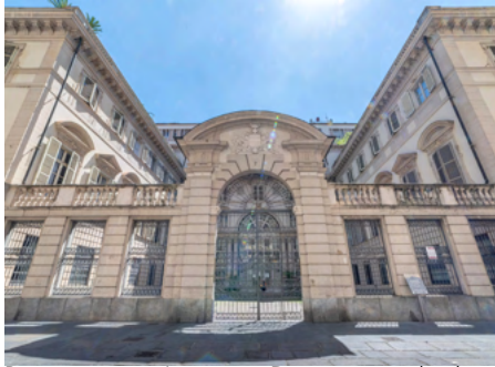
Prospetto su via Lagrange. Da qui si accede al cortile
