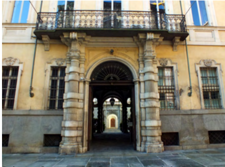
Palazzo Carpano - Palazzo Asinari di San Marzano, in via Maria Vittoria 4. Fotografia di Paola Boccalatte, 2014.
