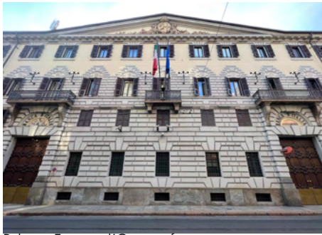
Palazzo Ferrero d'Ormea, facciata esterna
