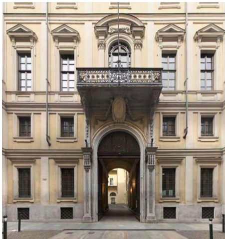
Facciata Palazzo Valperga Galleani
