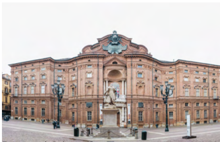
Facciata di Palazzo Carignano
