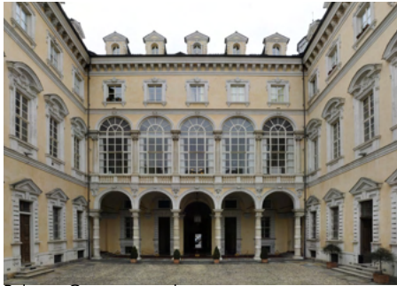
Palazzo Graneri, cortile interno
