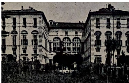
Prospetto verso il giardino. In De Bernardi Ferrero, 1959
