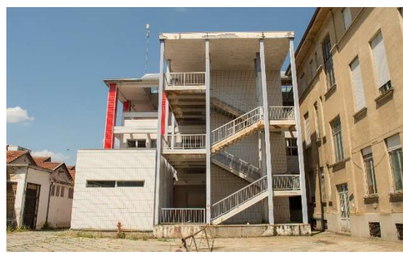
Figura 44- scala di sicurezza adiacente alla palazzina uffici
