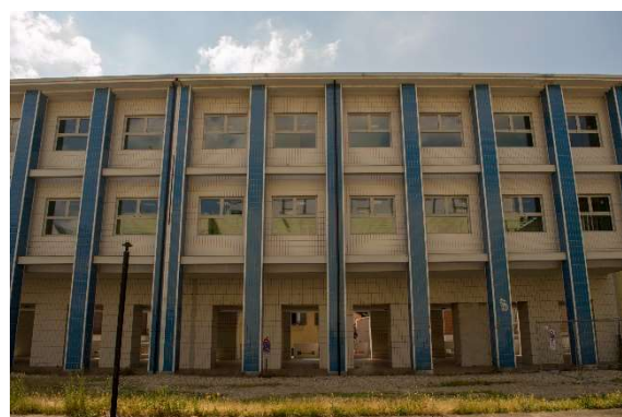
Figura 42- fronte est- interno cortile
