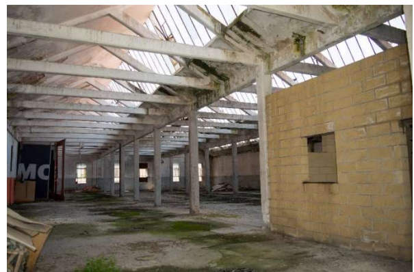
Figura 40- foto interno dell'edificio- foto di produzione propria
