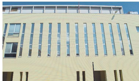
Figura 17- Parte del prospetto interno al lotto dell'edificio ospitante il teatro- 2024
