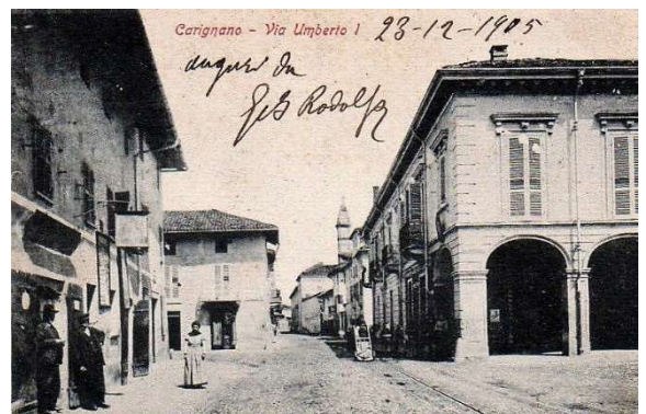
Figura 9- Via Umberto I- precedentemente alla realizzazione dell'edificio per la tessitura- Inizio del 19 secolo
