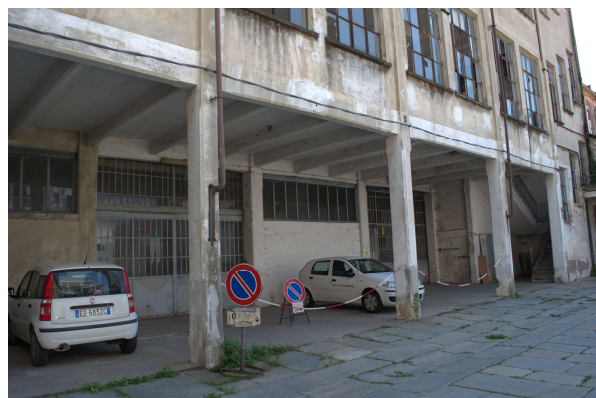
Figura 32- particolare piano terra Lingottino- foto di produzione propria.
