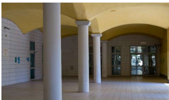
Figura 45- portici fronte est (lato cortile interno)
