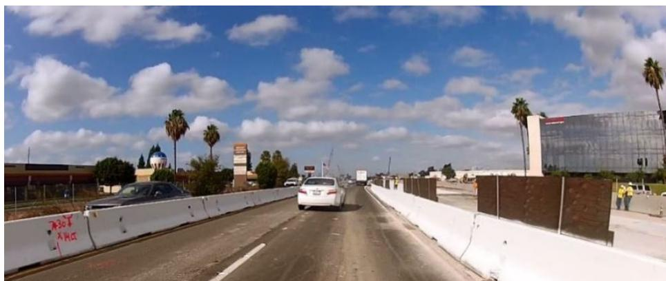
*Figura 5.2: Esempio di cantiere delimitato da New Jersey*
