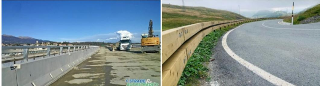
Figura 2.14: Esempi barriere composite
