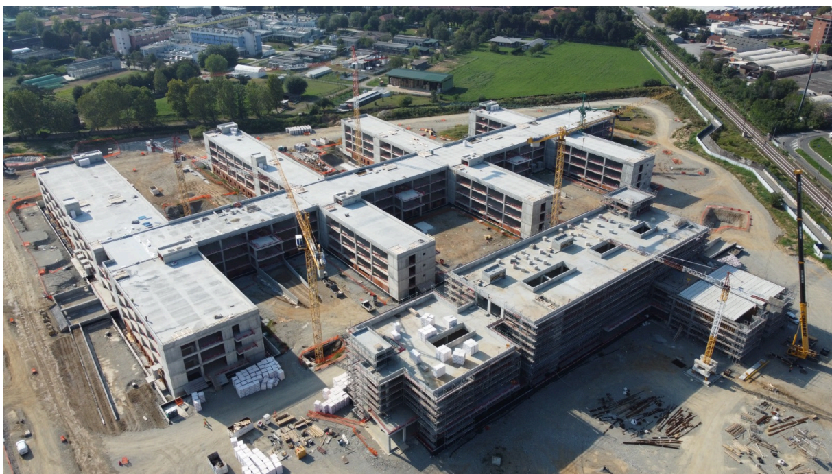
Figura 11. Panoramica dell'Edificio DA
