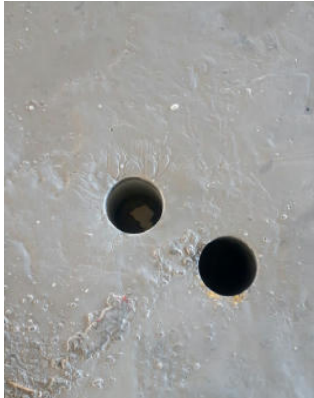
Figura 32. Foro estrazione carote
