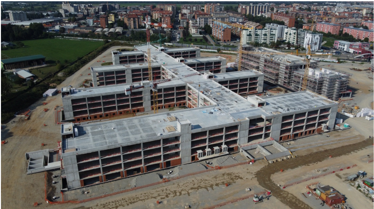
Figura 17. Edificio DR – Vista Sud
