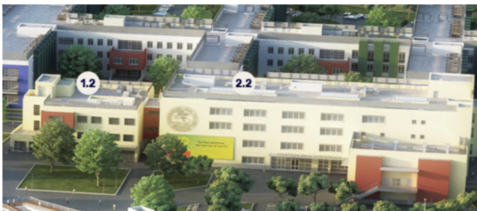
Figura 6. Panoramica Edificio DA
