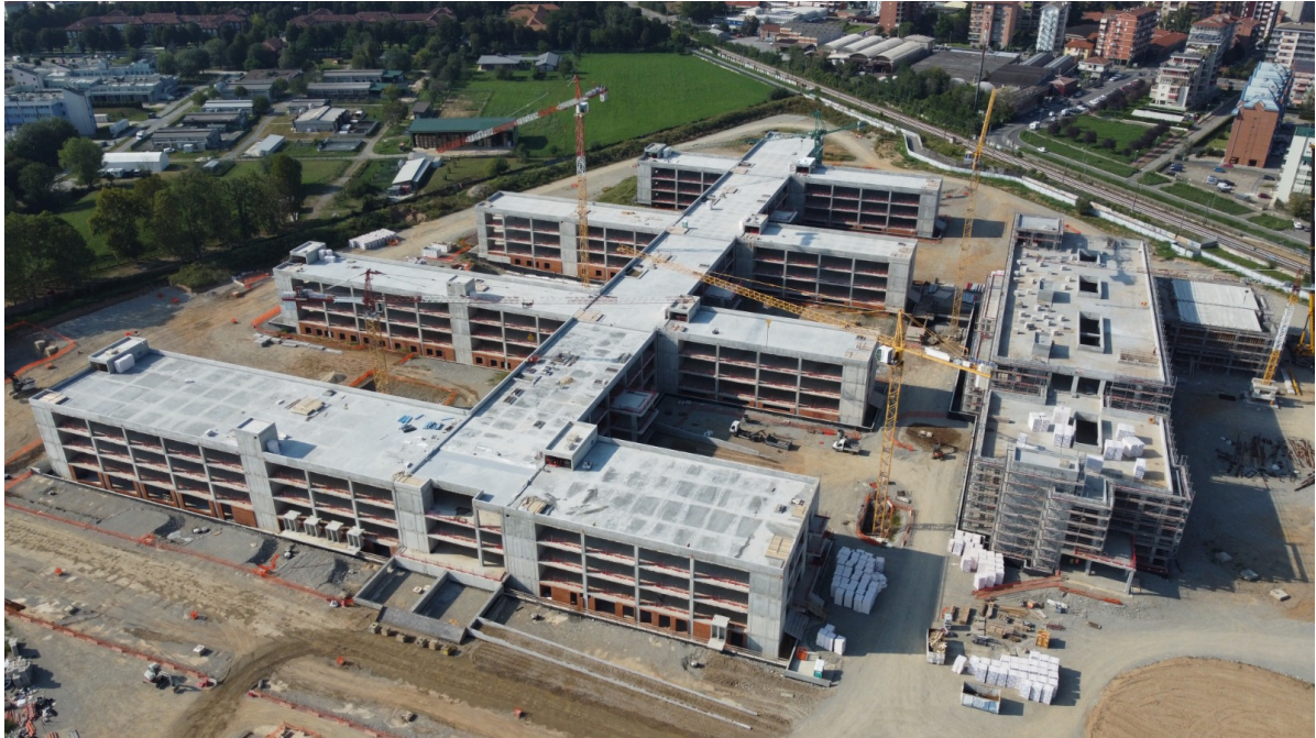
Figura 16. Edificio DR – Vista dall’alto
