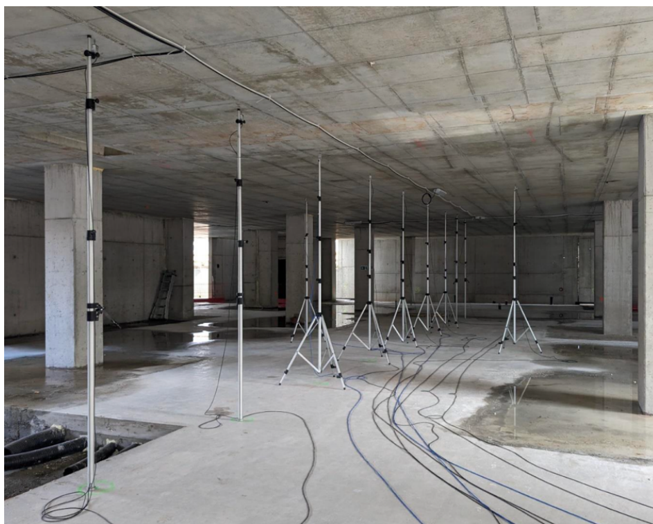
Figura 28. Trasduttori di spostamento installati su aste telescopiche per la misura degli abbassamenti
