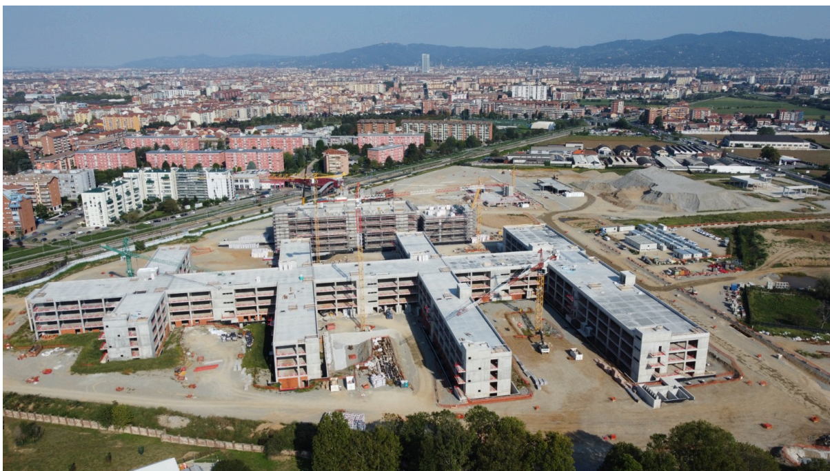
Figura 10. Vista panoramica dell'intera area di cantiere
