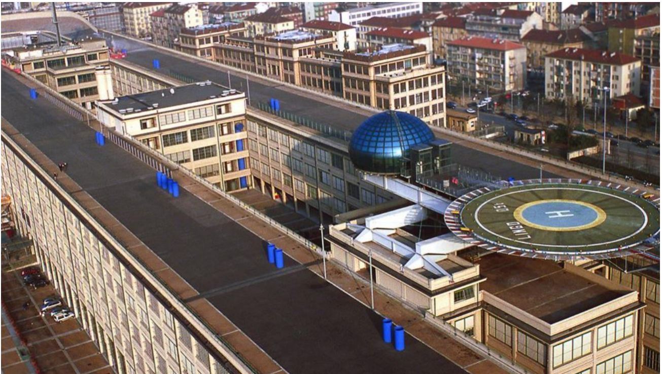
Figura 63: Tetto del centro commerciale 'Lingotto'. [35]
