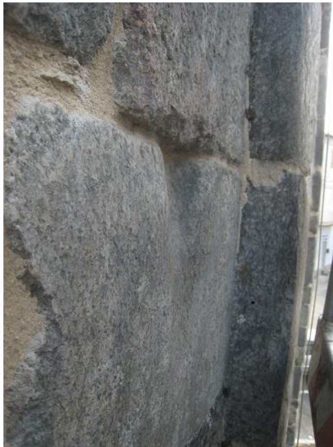
Dettaglio di un conco del campanile
