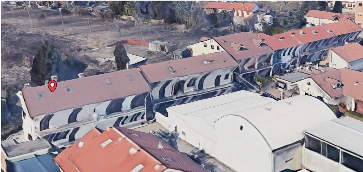
FIGURA 35: TETTI BIANCHI NEI PRESSI DELL'IMPIANTO FOTOVOLTAICO (INDICATO CON UN SEGNALINO IN ROSSO LA POSIZIONE DELL'IMPIANTO FV)
