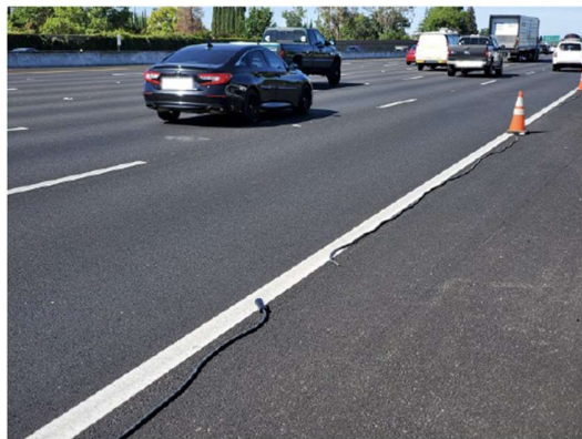
Figura 111_ Installazione parallela al flusso veicolare dei tubi pneumatici del sistema WAS_ Chiusura perimetro area di cantiere
