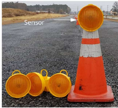
Figura 52_Installazione dell'Unità di rilevamento delle intrusioni del sistema Intellicone su un dispositivo standard di delimitazione di cantiere
