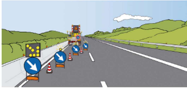
Figura 15_ Chiusura della corsia di sorpasso: Installazione del raccordo obliquo completata
