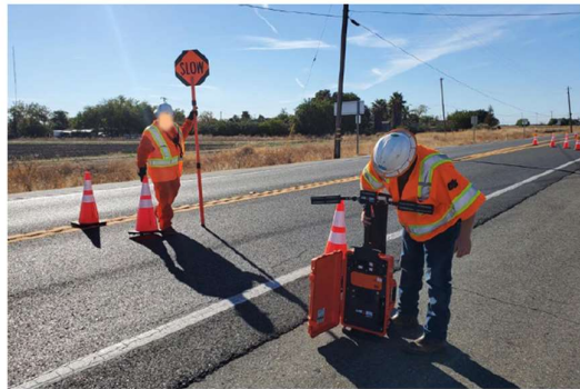
Figura 125_Dettaglio dell'installazione del dispositivo AWARE in configurazione Sentry_ attività di "segnalamento"
