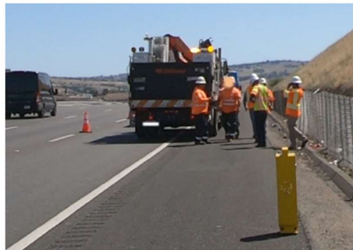
Figura 118_Installazione del dispositivo Single Sentry Beam _ laser orientato in direzione perpendicolare al flusso veicolare
