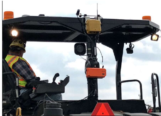
Figura 60_AWARE in configurazione di "Individuazione delle intrusioni di corsia"
