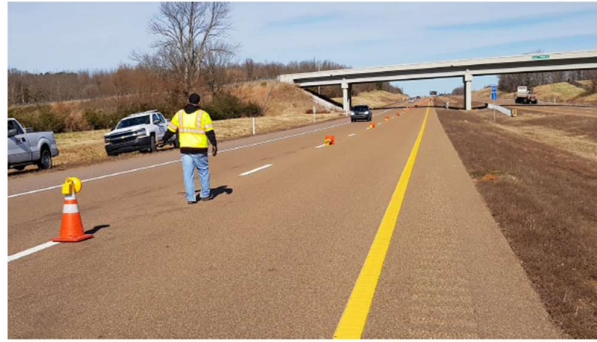
Figura 105_Abbattimento dei coni con "sensor lamp" a causa delle turbolenze generate dal passaggio di mezzi pesanti
