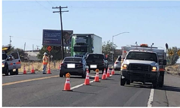
Figura 124_Installazione dei "sensor lamp" sui dispositivi di delimitazione dell'area di cantiere
