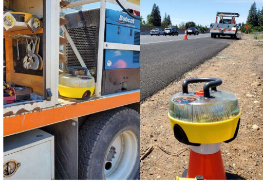
Figura 114_ Installazione dei dispositivi di allarme collettivi (PSA) del sistema Intellicone
