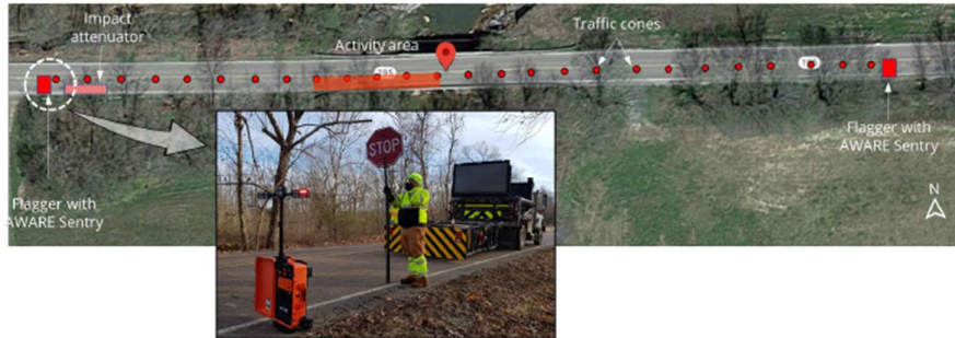
Figura 103_ Installazione nell'area di cantiere del sistema AWARE Sentry_ Prima configurazione di cantiere
