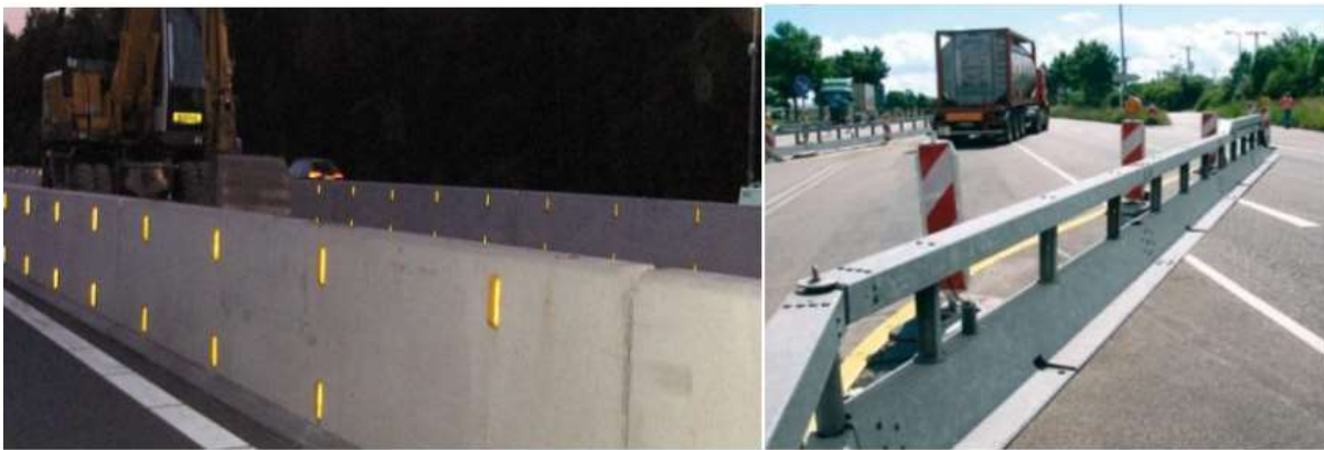
Figura 36_Dispositivi modulari di ritenuta; a destra in calcestruzzo prefabbricato; a sinistra in metallo
