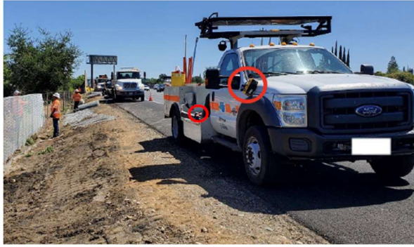
Figura 112_installazione dei dispositivi di allerta collettivi (PAC) sui mezzi di servizio
