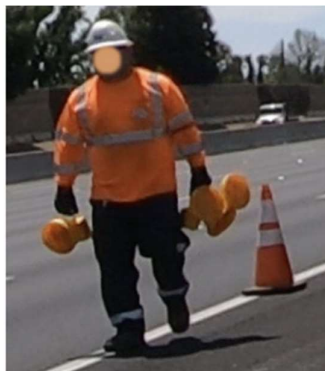
Figura 115_Procedure di installazione e rimozione dei "sensor lamp" _ esposizione del personale al flusso veicolare
