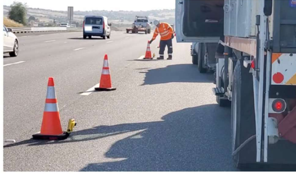
Figura 117_Procedure di installazione e rimozione dei dispositivi SonoBlaster _ esposizione del personale al flusso veicolare
