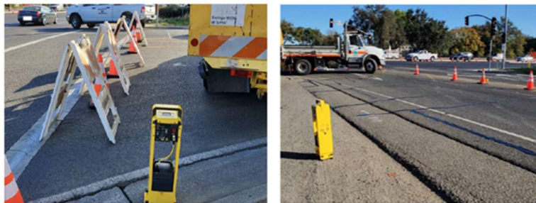
Figura 127_ Installazione delle due unità Single Sentry Beam _ Chiusura delle due testate della corsia di cantiere
