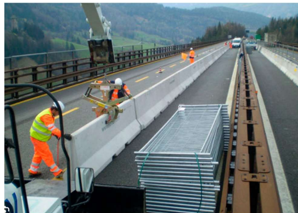
Figura 25 _Disposizione delle barriere "New Jersey" sulla carreggiata
