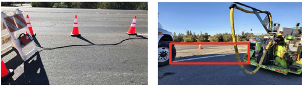
Figura 130__Immagini di dettaglio _ Installazione lungo il perimetro del cantiere dei tubi pneumatici del sistema WAS
