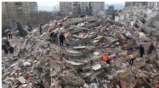
Figura 1.4: Struttura crollata in Turchia nel terremoto del 2023 [5]
