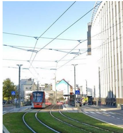
Figura 2.20: Linea aerea di contatto di una rete tranviaria
