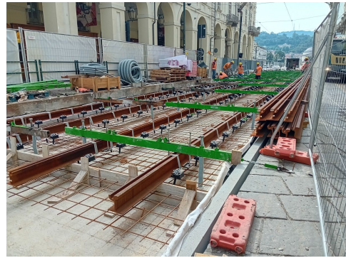
Figura 4.2: Posa delle rotaie Phoenix in Via Po (TO)
