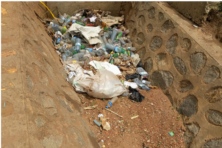
Figura 12 Rifiuti in plastica che ostruiscono i canali di scolo a Gulu, Uganda (Berkley, 2020)
