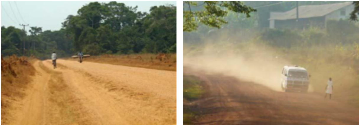
Figura 8 Esempi di strada nazionale non asfaltata (Ministry of Work and Transport, 2013)
