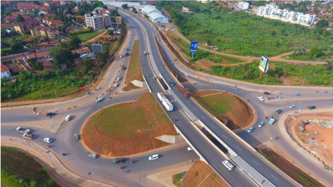
Figura 9 Esempio di strada asfaltata e modernizzata a Kampala, capitale dell'Uganda (Ministry of Work and Transport, 2022)
