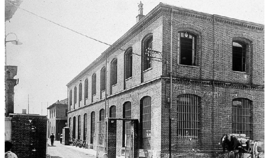
Fig.21: La fabbrica di mattoni rossi
