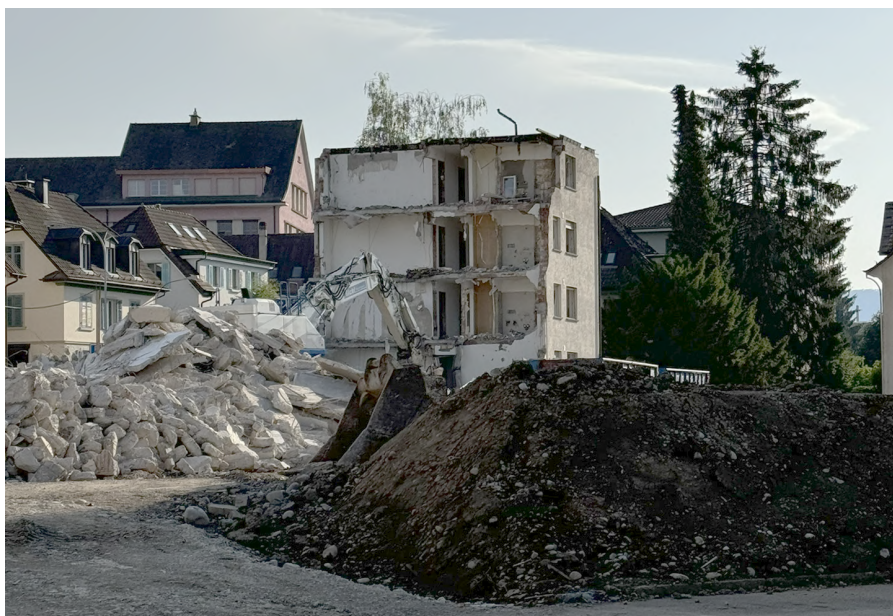
Figura 7.4: La demolizione dell'edificio oggetto del caso studio.
