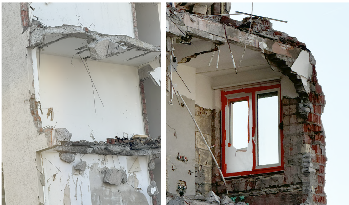
Figura 7.9: Immagini acquisite durante la demolizione dell'edificio in Schulstrasse 27, Schlieren. Si può notare come il solaio sia in calcestruzzo e come nelle pareti non sia presente nessun tipo di isolamento ma solamente mattoni
