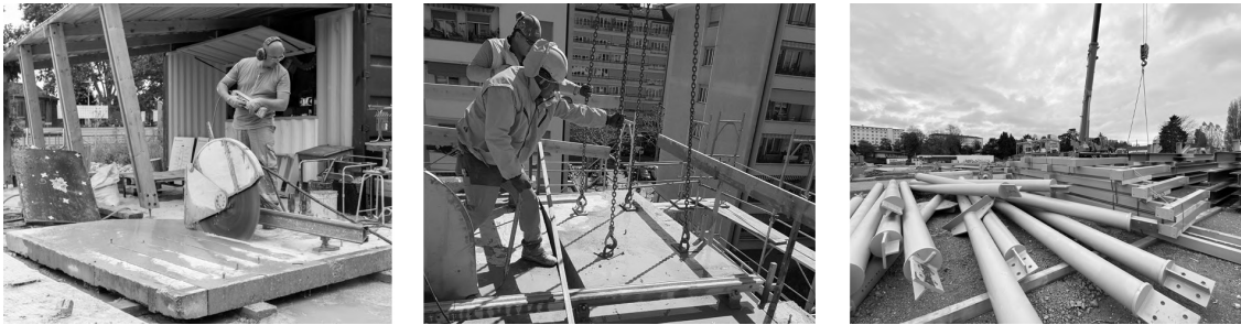
Figura 5.8: Decostruzione selettiva strutturale, da destra: un operatore taglia tramite apposita sega una soletta in calcestruzzo, operazione di rimozione della soletta tramite gru, elementi portanti di una pista di pattinaggio decostruita. Fonte immagini: [49].
