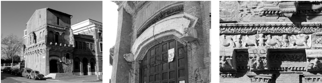
Figura 5.3: Dettagli della Casa dei Crescenzi, come le semicolonne e paraste del lato sud caratterizzate dai capitelli con laterizi risalenti ad antichi monumenti e i mattoni di recupero impiegati nell'arco ribassato del portale d'ingresso. Fonte immagini: [44].
