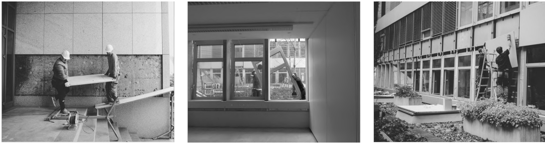
Figura 5.7: Decostruzione selettiva non strutturale dell'edificio per uffici Orion a Zurigo. Da destra: rimozione manuale del rivestimento in pietra, rimozione delle finestre tramite ventose, rimozione della lamiera e dell'isolamento posto in facciata. Fonte immagini: [49].
