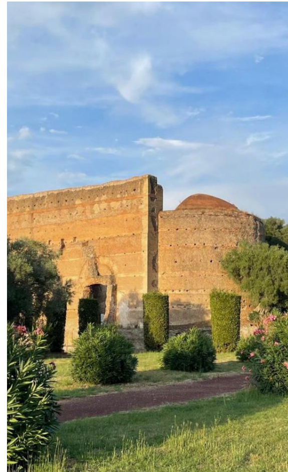
A sinistra: dettaglio posteriore della Sala dei Filosofi, Villa Adriana, Tivoli.
