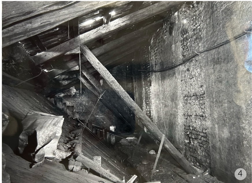
Fig. 3: in questa foto si legge sullo sfondo il sistema strutturale storico che era presente e l'interdipendenza tra copertura e solaio. Fig. 4: è possibile osservare uno degli ambienti alterati dall'inserimento dei lucernari che dovevano illuminare gli ambienti sottostanti adibiti a museo.
