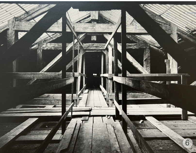
Fig. 5: Il nodo trave di cantonale-puntone rappresenta un punto critico nella struttura, ed è chiaramente documentato che questo specifico elemento sia stato consolidato attraverso l'inserimento di una putrella. Fig. 6: La copertura storica nella zona di uno dei lucernari dopo il loro smantellamento.
