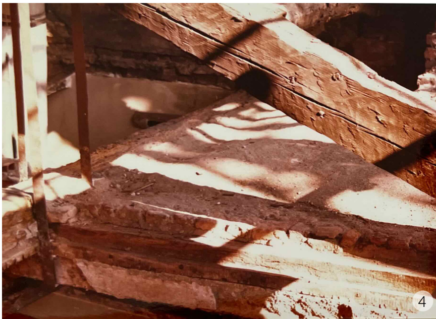
Fig. 3: Solaio composto da voltine in foglio. Fig. 4: particolare dell'appoggio delle volte in mattoni alle travi in legno.
