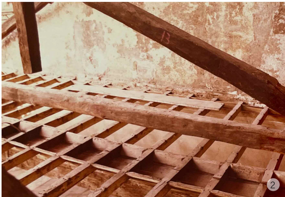
Fig. 1: solaio ligneo seicentesco visto dal basso Fig. 2: foto scattata durante la fase di smantellamento delle strutture del solaio, si legge chiaramente l'orditura del solaio seicentesco
