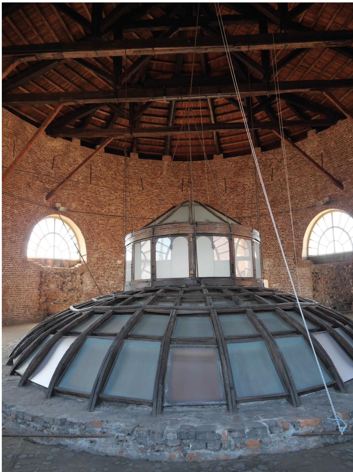
Foto 31, Tamburo ellittico, l'intervento ha previsto la rimozione degli elementi metallici inseriti in epoche successive e il restauro degli elementi lignei della struttura originaria.
