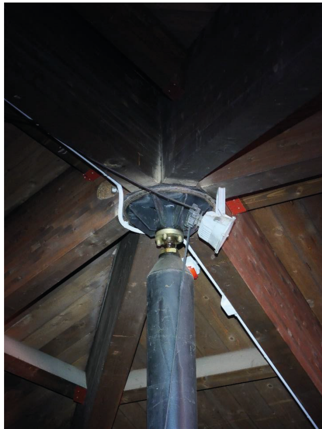
Foto 26, pilastri della nuova struttura posizionati in corrispondenza delle porzioni di muro di spina demoliti.
