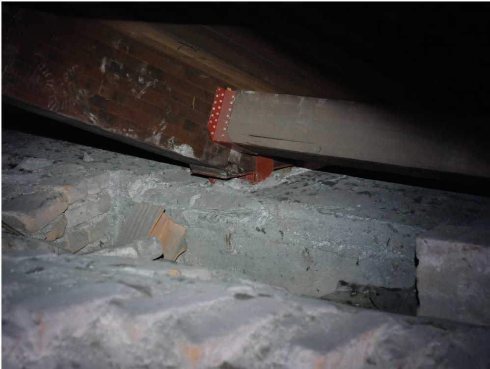
Foto 28, cordolo di irrigidimento perimetrale in cls.
