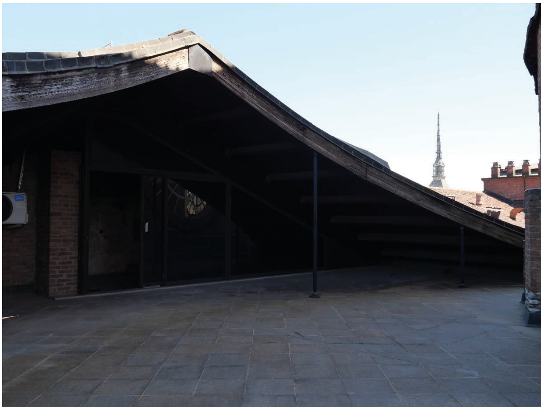
Foto 33, Copertura di una porzione del terrazzo realizzato intorno al tamburo ellittico
