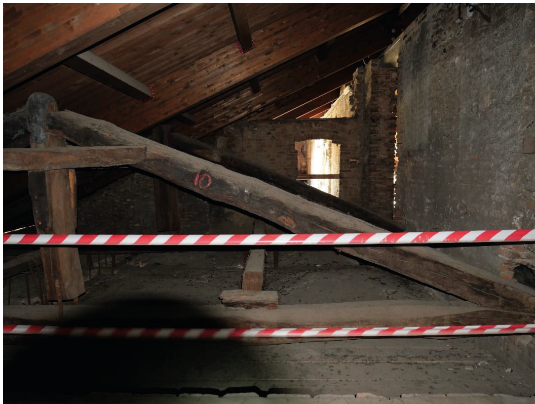
Foto 17, Testimonianze delle costruzioni seicentesche, sistema di capriate seicentesche che aveva il compito di sostenere la vecchia struttura delle coperture.
