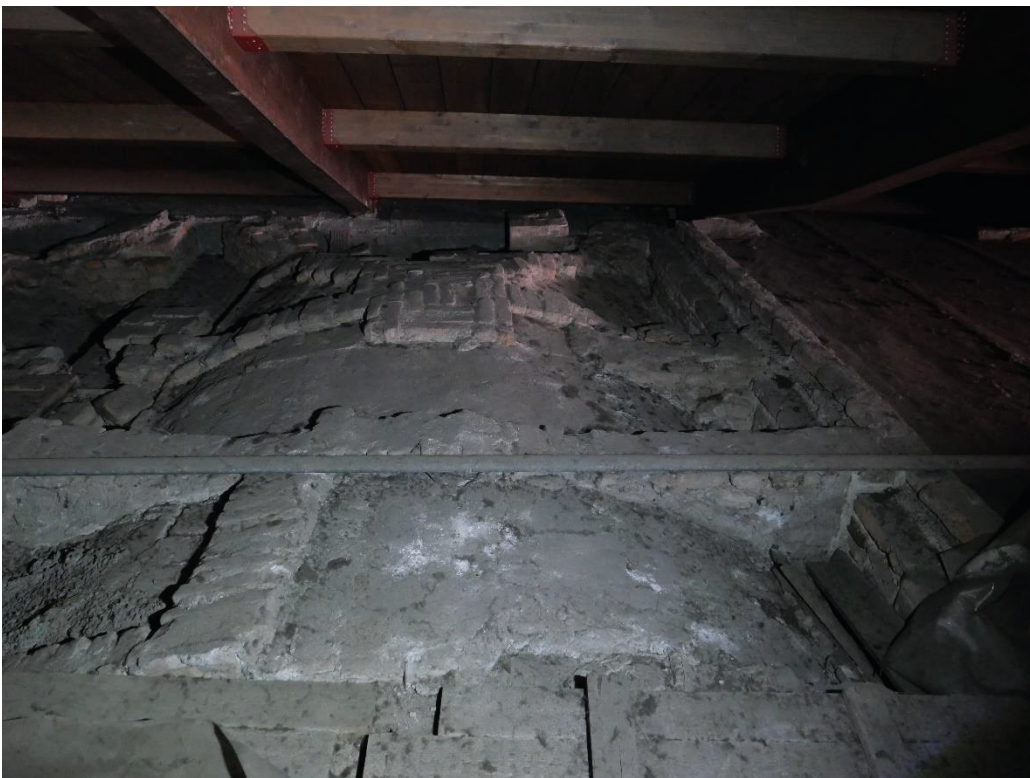
Foto 15, Testimonianze delle costruzioni seicentesche, volta in mattoni con irrigidimenti
