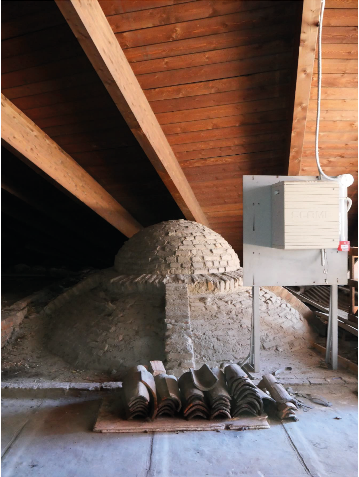
Foto 16, Testimonianze delle costruzioni seicentesche, estradosso volta in mattoni.
