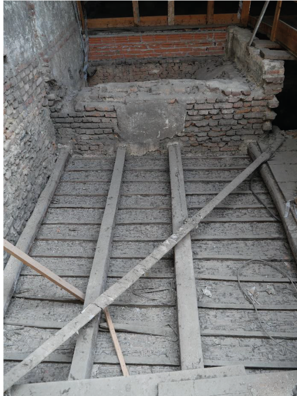
Foto 25, solaio ligneo seicentesco
