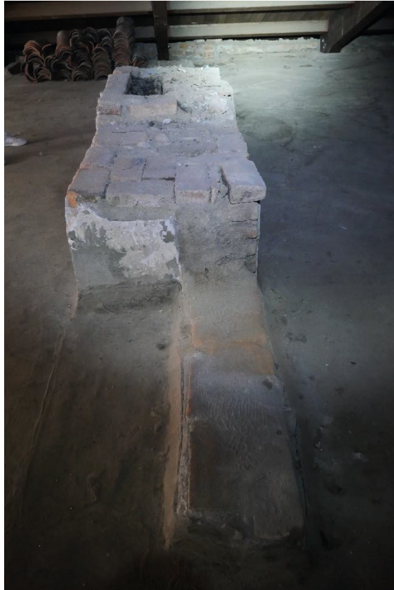
Foto 13, Muro seicentesco parzialmente demolito.
