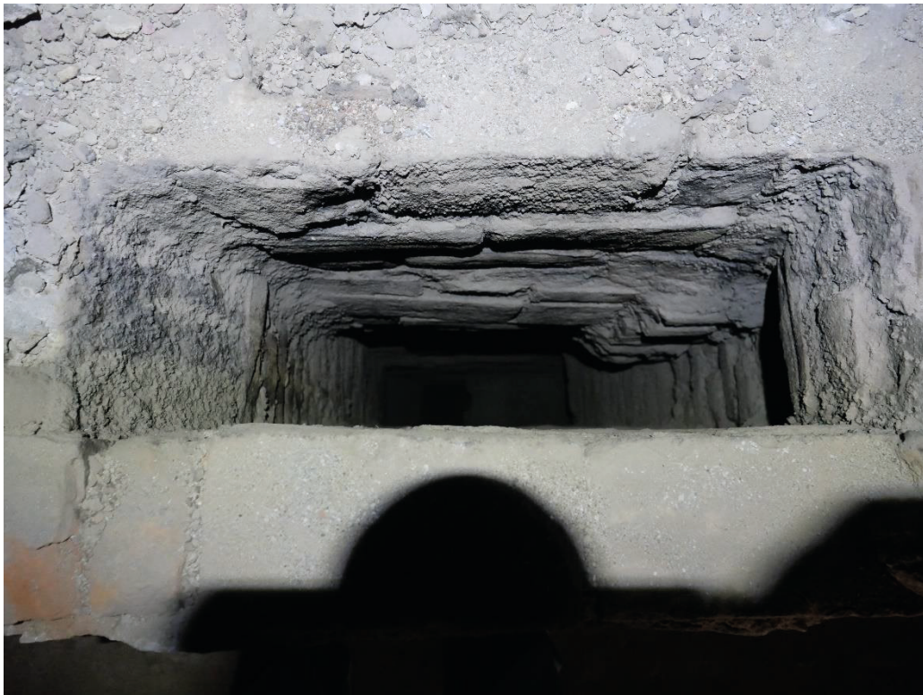
Foto 14, Presa d'aria di un camino visibile tramite il taglio di porzione di un muro seicentesco
