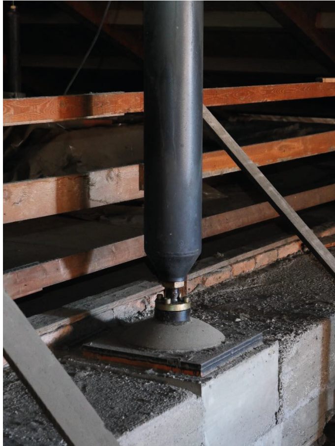
Foto 27, pilastri della nuova struttura posizionati in corrispondenza delle porzioni di muro di spina demoliti.
