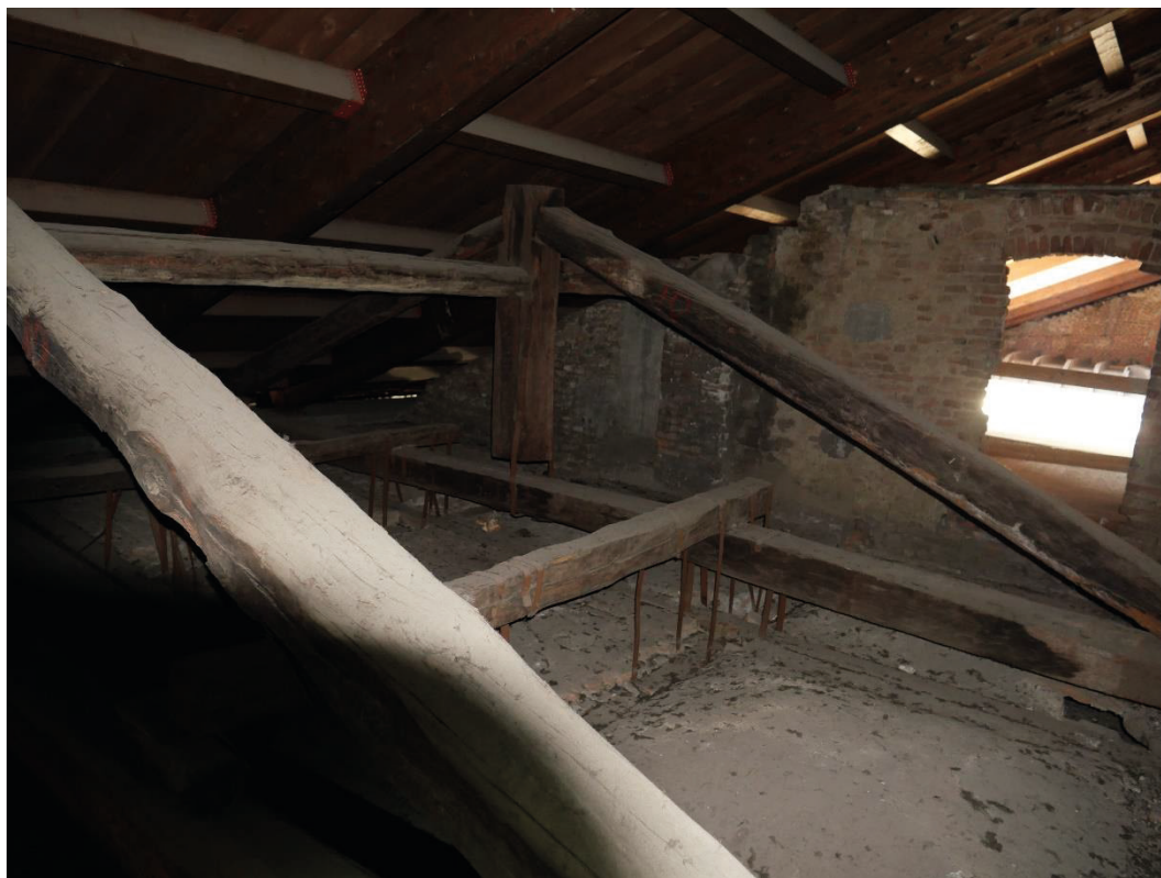
Foto 18, Sistema di capriate seicentesche, si noti come il solaio di voltine in foglio sia stato appeso tramite imbretellamenti alle capriate.
