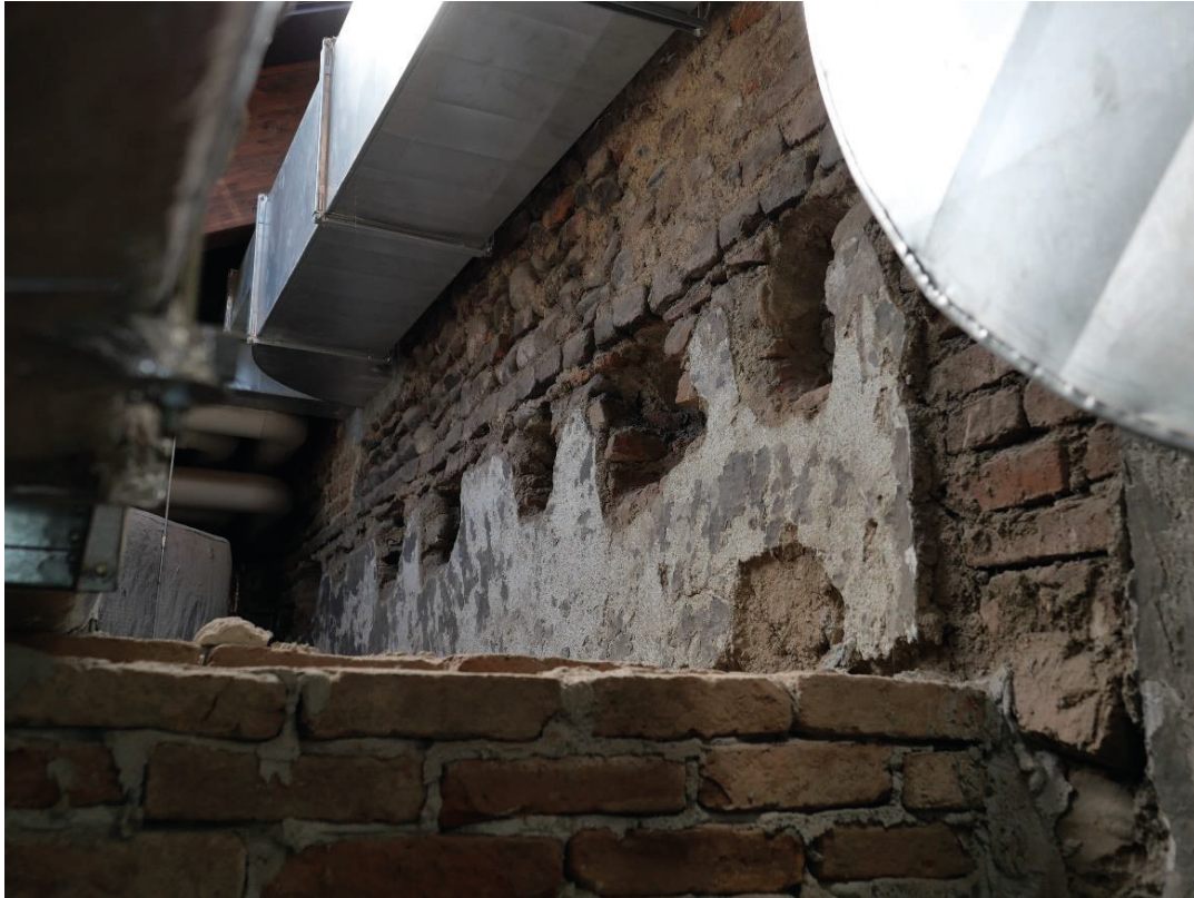
Foto 4, Testimonianze della copertura seicentesca
