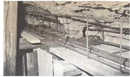
Figura 1 Esecuzioni di architravi in sottomurazione, nei muri perimetrali (in G. CARBONARA, Restauro e Cemento in architettura , pp. 30-33)
