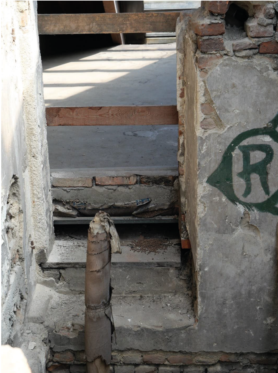
Foto 29 , il nuovo solaio, in lamiera grecata con getto in cls, è stato posizionato al di sopra dei solai preesistenti, esautorandoli e riducendoli a controsoffittature.
