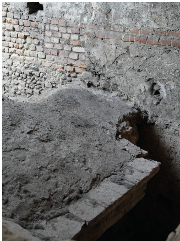
Foto 24, Cornicione dell'edificio seicentesco
