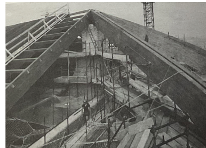
Figura 8 La nuova struttura del tetto in legno lamellare è costituita da una capriata reticolare di circa 27 m di luce, vincolata tramite un appoggio fisso ed uno scorrevole su cuscinetto di neoprene (in G. CARBONARA, Restauro e Cemento in architettura , pp. 214-225)
