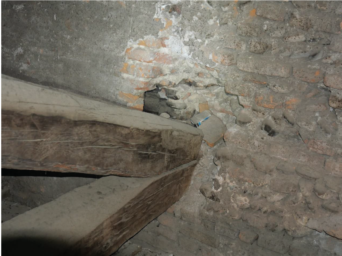
Foto 19, Connessione capriata-muro seicentesco
