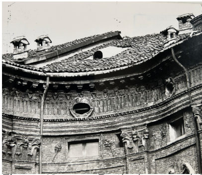
Figura 42 Particolare del muro di prospetto curvilineo su cui la copertura poggia. (IUAV,Archivio Progetti, Fondo Andrea Bruno, Scatola F4)
