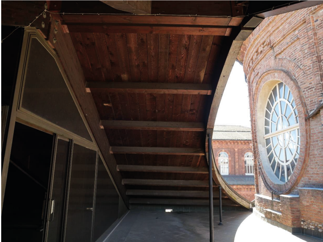
Foto 32, Copertura di una porzione del terrazzo realizzato intorno al tamburo ellittico
