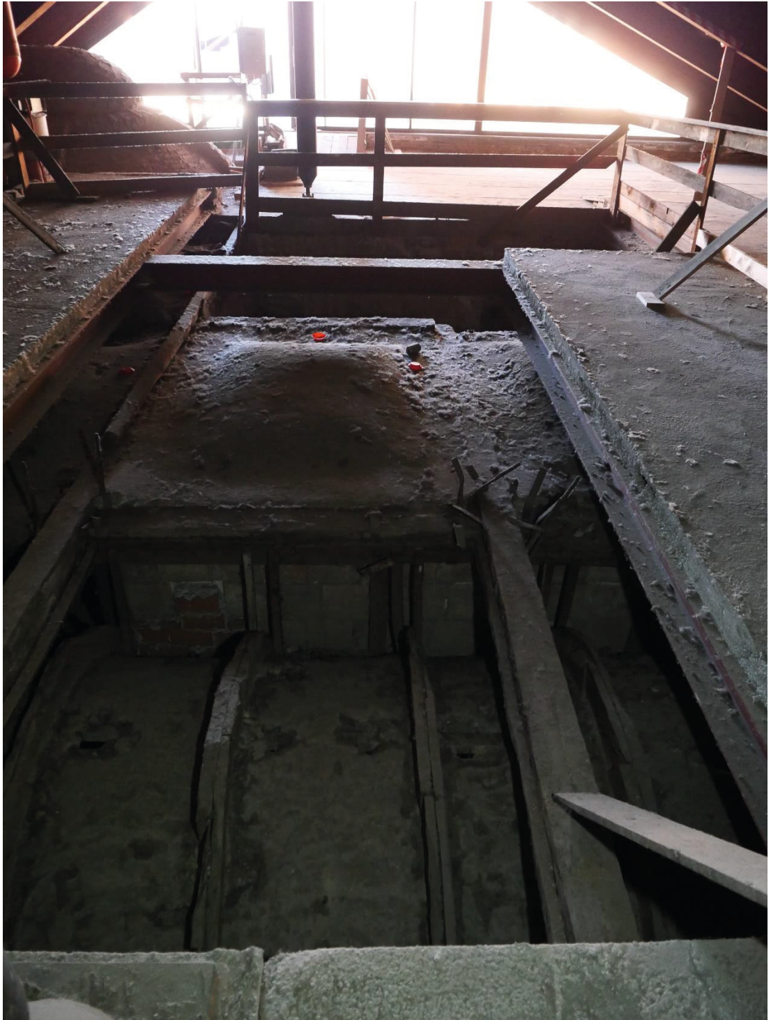
Foto 30, il nuovo solaio costruito al di sopra dei solai esistenti.
