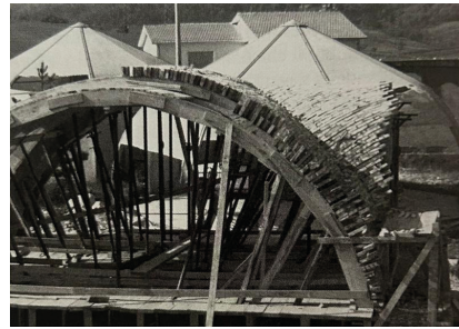
Figura 10 Modello al vero della volta lunettata realizzato per sperimentare la disposizione dei mattoni (in A. Giuffrè, Leggendo il libro delle antiche architetture , Gangemi editore, Roma 2011)
