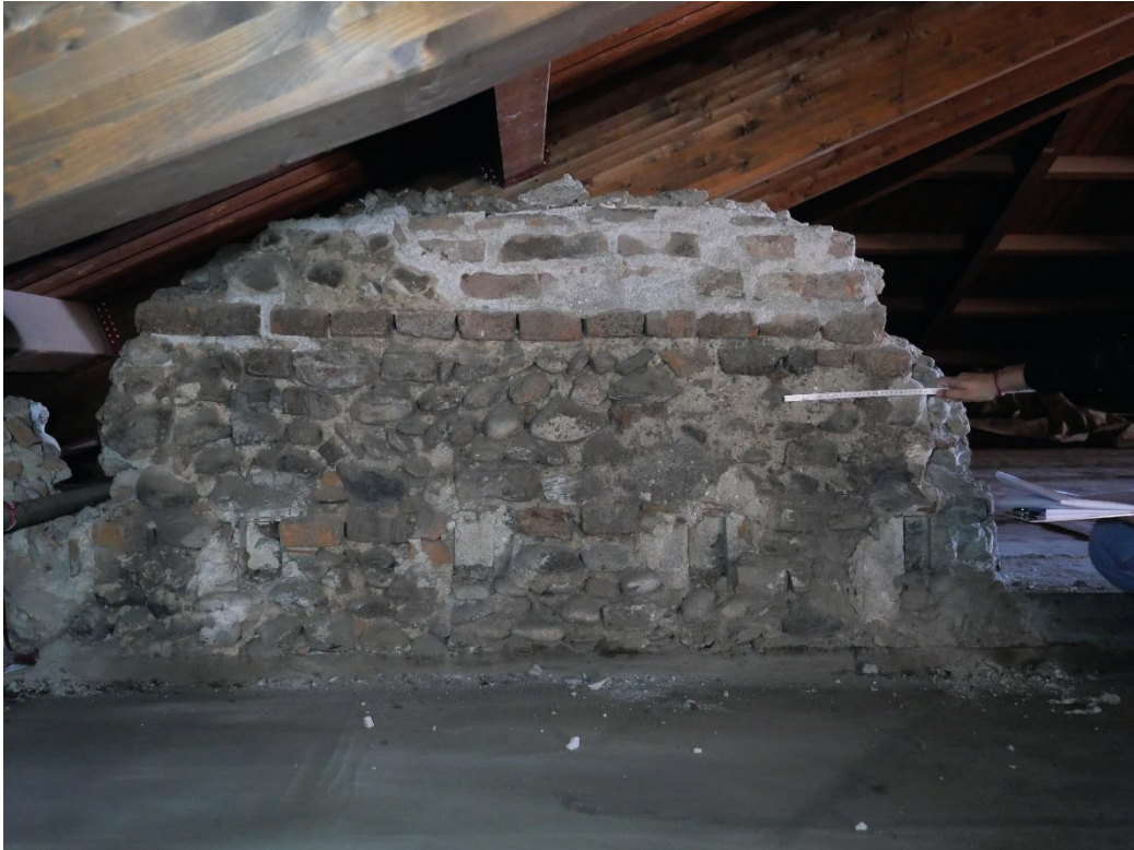
Foto 12, Muro seicentesco parzialmente demolito.
