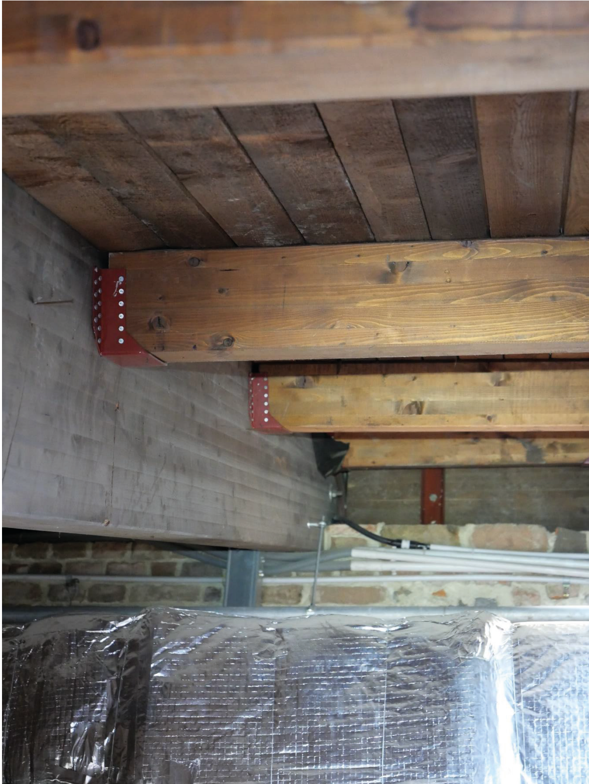
Foto 11, Connessione tra puntone ed arcarecci.
