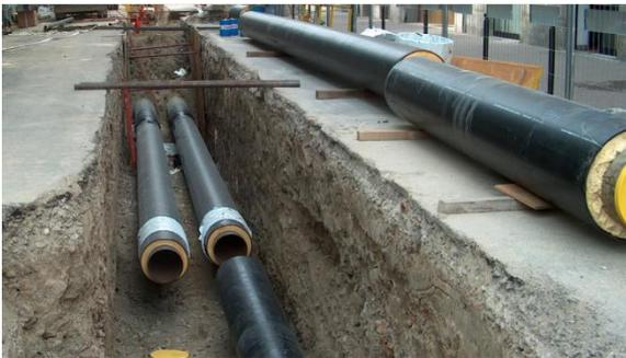
**[Fig. 25]** Tipologia reale dell'inserimento di tubature per le reti di teleriscaldamento. Fonte: <https://www.airu.it/annuario-airu-situazione-del-teleriscaldamento-al-31-dicembre-2015/>
