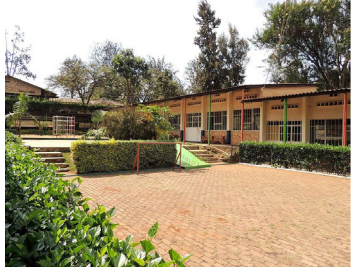
(Fig.24), Former school the École Belge de Kigali, (La Rentrée Des Classes À L'École Belge, n.d.)
