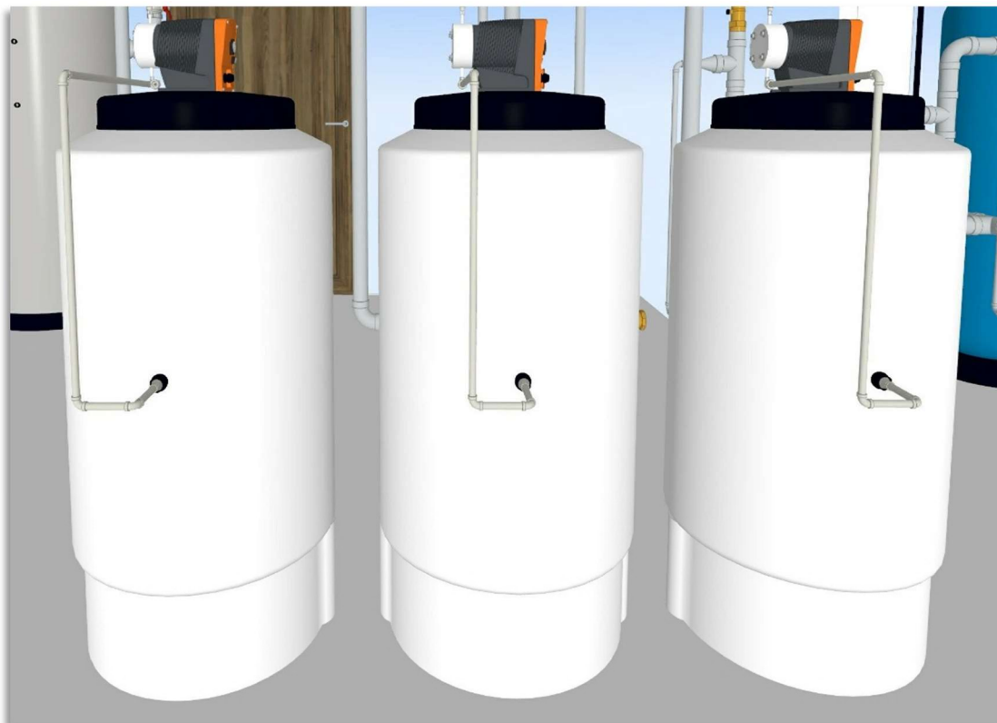
Figura 4.34 Dosatori di additivi chimici
