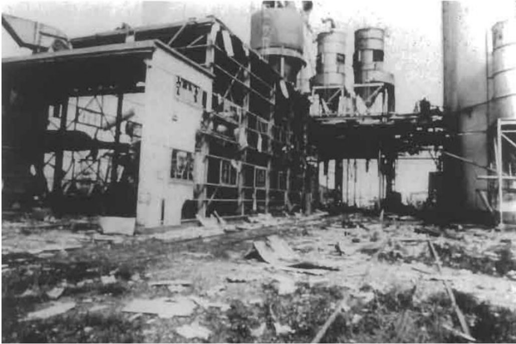
Figura 17 - Danni nell'area di scarico ferroviario
