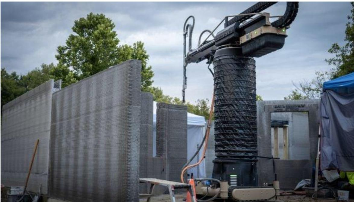
*Figura 52: macchinario AM per la realizzazione di case*
