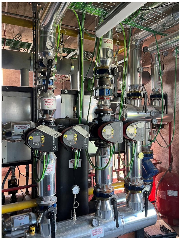
Figura 34 -Collettore alta temperatura - RSA Cervetto
