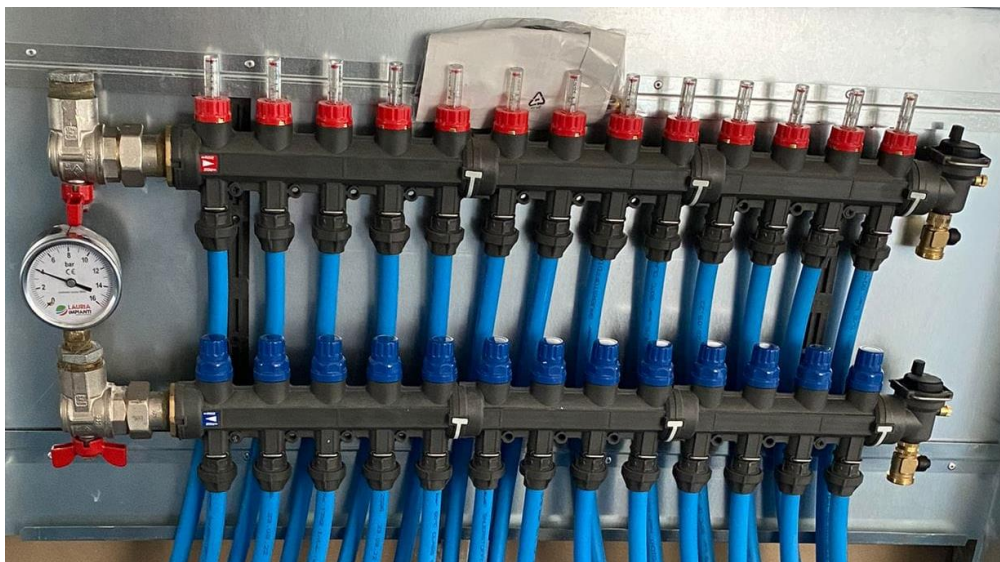
Figura 42 - Test tenuta sistema radiante
