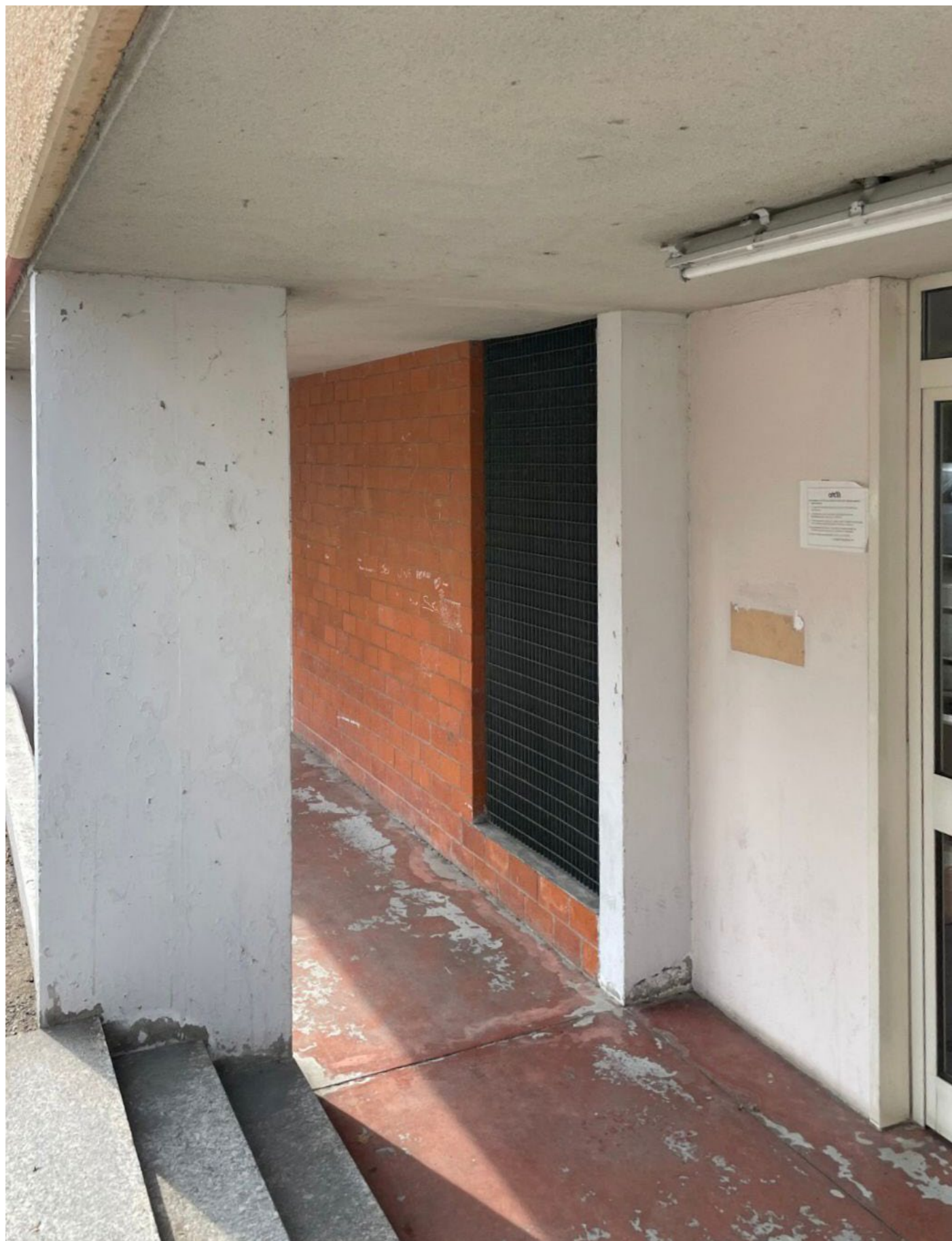
Fig. 216: Accesso all'edificio nord-ovest, fronte strada
