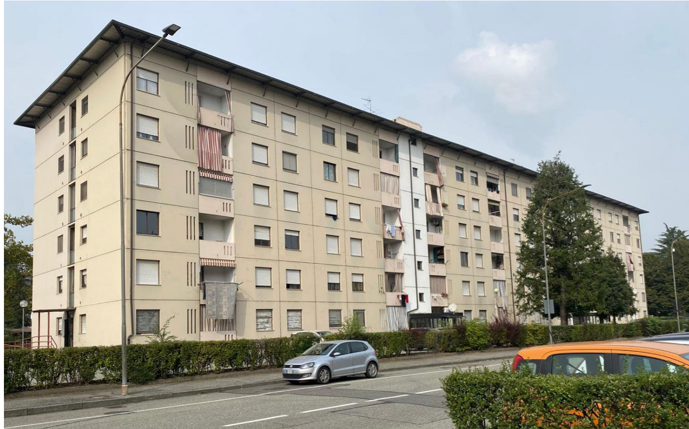
Fig. 2.21: Facciata edificio sud-est, ed. 4.
