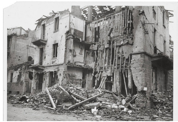
Fig.1.13: Via Prangelato ang. Via Frassineto. Effetti prodotti dai bombardamenti dell'incursione aerea del 28 Novembre 1942, Archivio Storico della Città di Torino.
