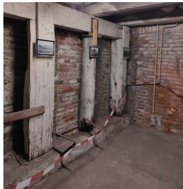
10. Rinforzi murari del rifugio
