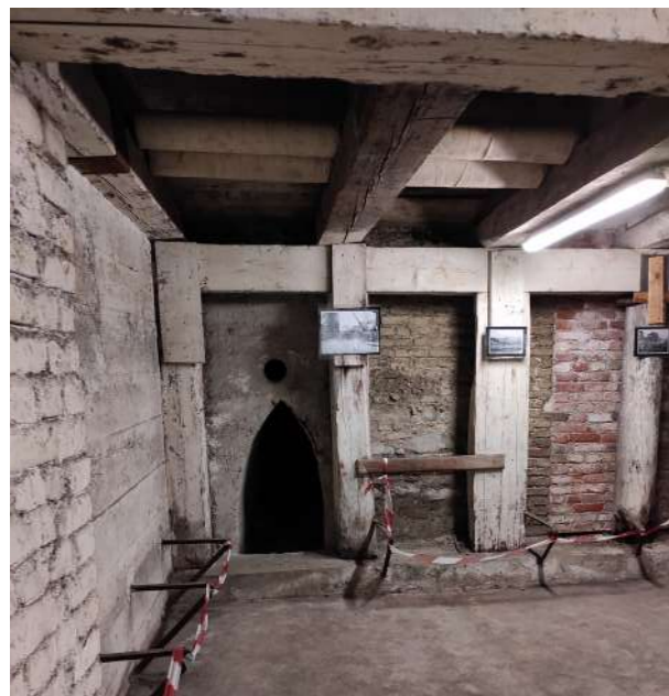
9. Via di fuga collegata al cortile interno
