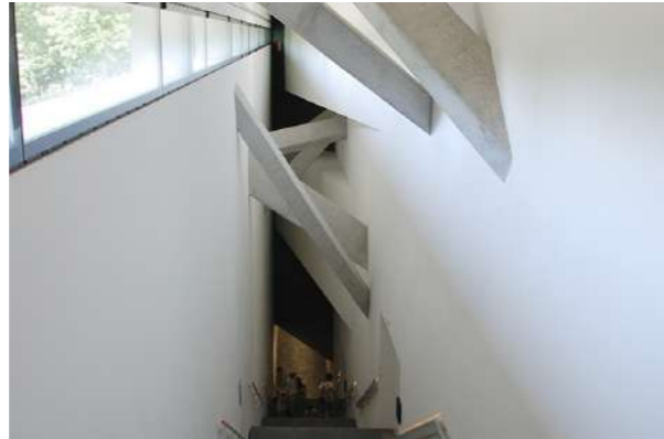
Percorso con travi in cemento
