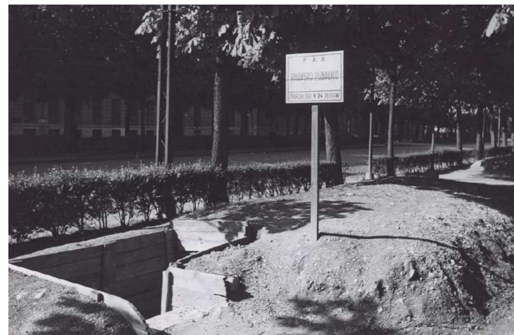
s.l., esterno di un Ricovero Pubblico di Protezione Antiaerea "Trincea per n. 24 persone".
