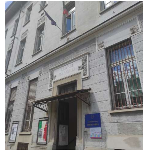
2. Ingresso principale su via Santhià
