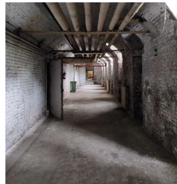
11. Corridoio centrale del piano interrato
