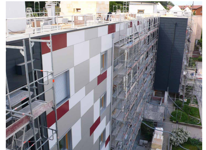
Fig. 72: Cantiere dettaglio balconi
