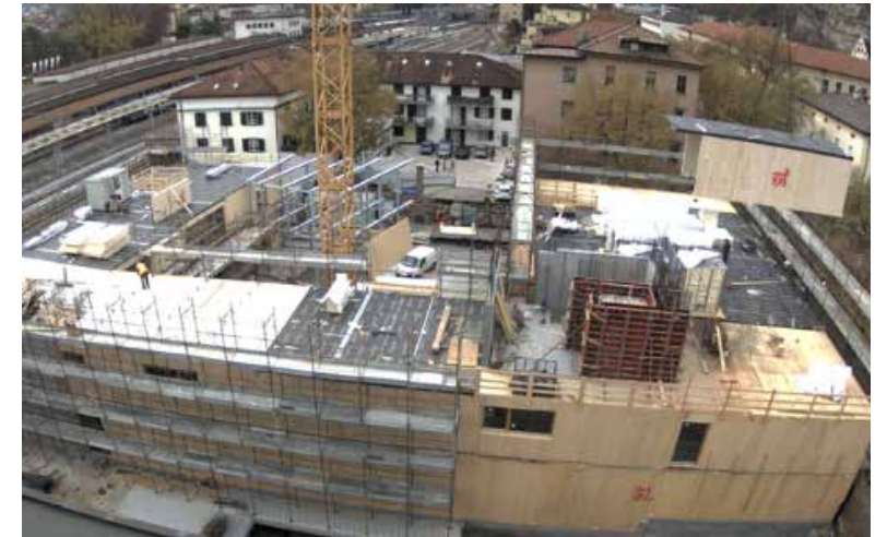
fig. 87: foto di cantiere fonte: foto della società Collini Lavori S.p.a.
