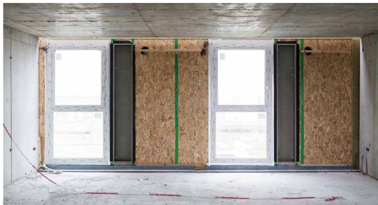
Fig 94: immagine dall'interno dell'edificio del pannello prefabbricato appena istalato
