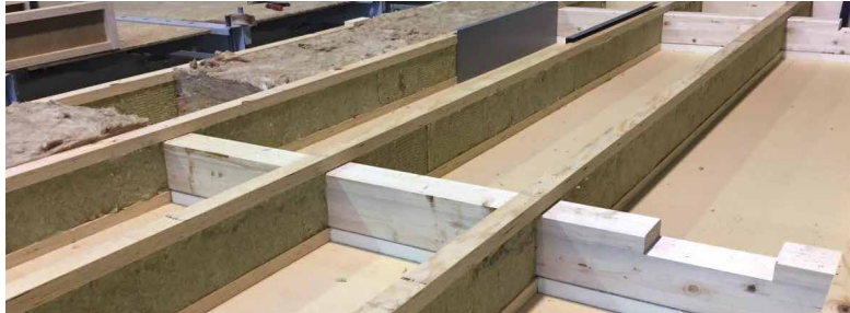
Fig. 68, 69, 70: Isolamento termico in prefabbricazione
