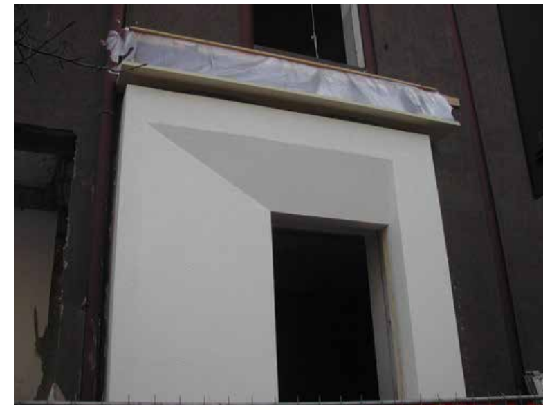
fig. 51: Focus sulla posa del pannello in polistirene espanso sagomato off.site
