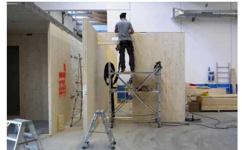
fig. 82: assemblaggio dei moduli in fabbrica fonte: foto di Giulio Boem
