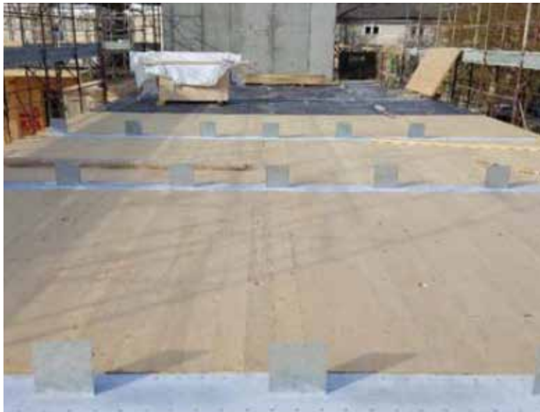
fig 85: Connessioni pre-montate in stabilimento in fresature dei pannelli, difficilmente realizzabili in opera fonte: Mauro Andreolli. (2018). Residenza universitaria Mayer, Trento. Ciclo di seminari tecnici, fabbricalegno.
