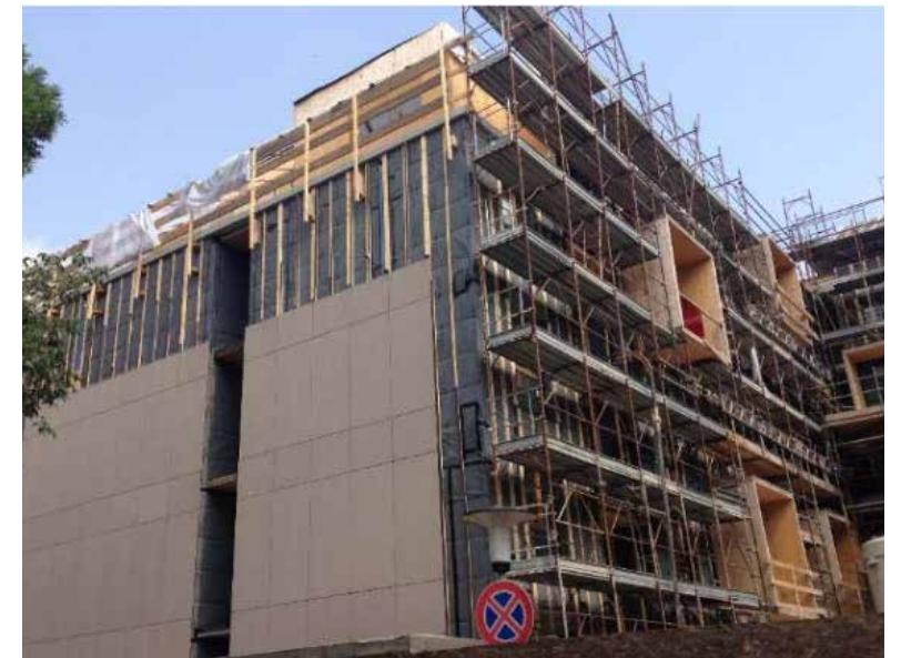
fig 88: cantiere, rivestimento delle facciate in pannelli di cemento fibro-rinforzato fonte: Massimo Scartezzini. (2018). La residenza Universitaria Mayer—Trento. Il progetto tra architettura e struttura. Ciclo di seminari tecnici, fabbricalegno.
