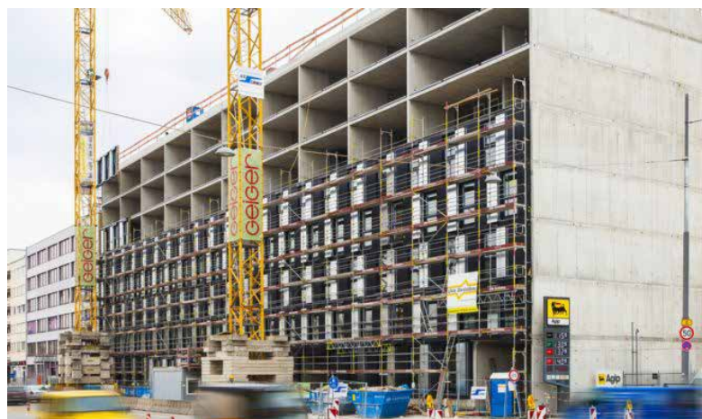
Fig 98: Immagine del cantiere
