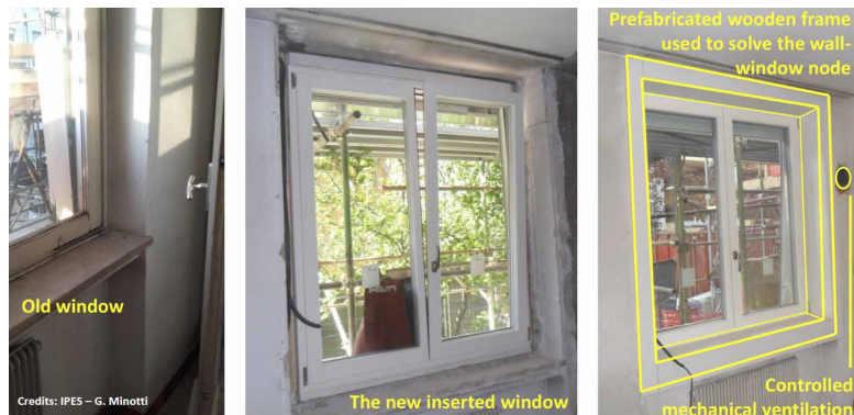
Fig. 75: Sostituzione dei serramenti fonte: http://www.sinfonia-smartcities.eu/it/demo-site/housing-complex-
