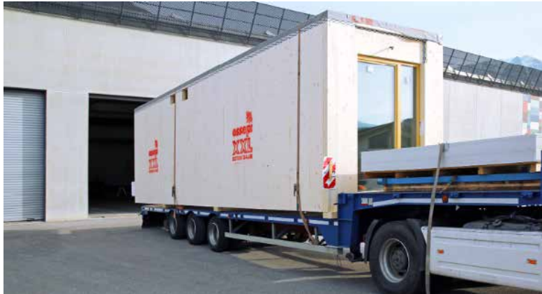
fig. 84: trasporto del modulo prefabbricato sul sito di cantiere fonte: foto di Paolo Simeone
