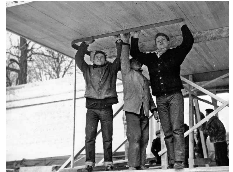
Fig. 13,14: installazione dei pannelli in legno per i soffitti e pavimenti. fonte: Jean Prouvé, Les Jours Meilleures house, 1956. (s.d.). https://www.jeanprouve.com/en/fiche/1956-5
