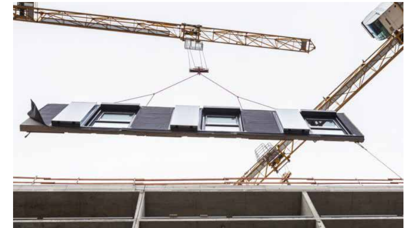
Fig. 99: Il pannello prefabbricato parte Rhinoceros Wall di Wood Beton.
