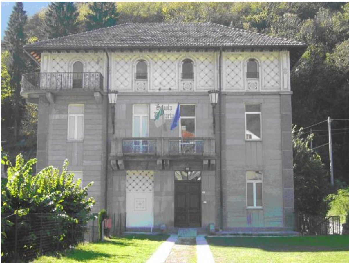
Figure 3 SCUOLA ELEMENTARE DI CRODO iii
