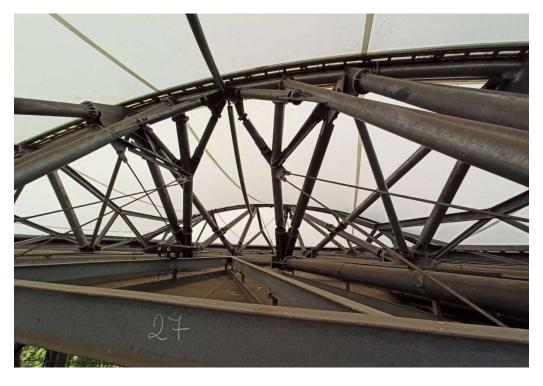
Figura 30 – L'ultima arcata del padiglione D4. Lo sbalzo ha lunghezza 18,5 m e sostiene due arcate reticolari
