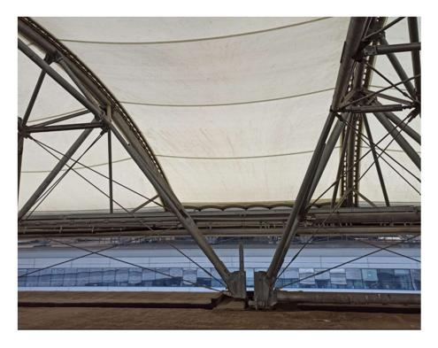
Figura 70 - Esempio di correnti inferiori incernierati alla trave in CA (la quale è incastrata a terra)
