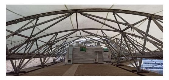
Figura 31 - Alcune arcate reticolari del padiglione C in successione. Si apprezzano le bielle ad arco curvilinee che collegano due arcate consecutive
