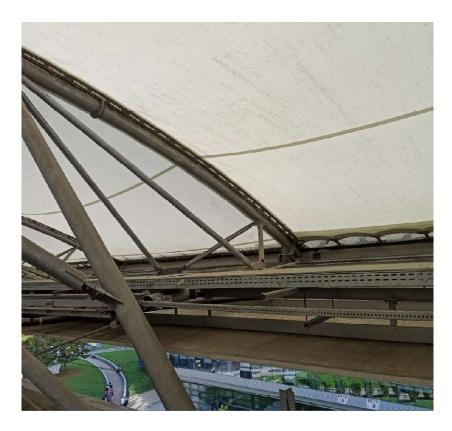
Figura 28 - Sbalzo laterale tipo di un'arcata reticolare
