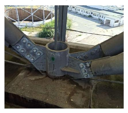
Figura 29 - Giunto di collegamento tra due arcate reticolari adiacenti
