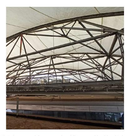
Figura 33 - Le due capriate a sbalzo in corrispondenza dell'interruzione del cordolo in CA, che stanno ad indicare il passaggio dal padiglione C al padiglione D
