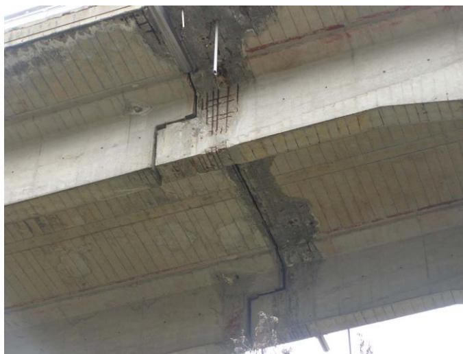
Figura 1: Sella Gerber di un impalcato in calcestruzzo armato [4]
