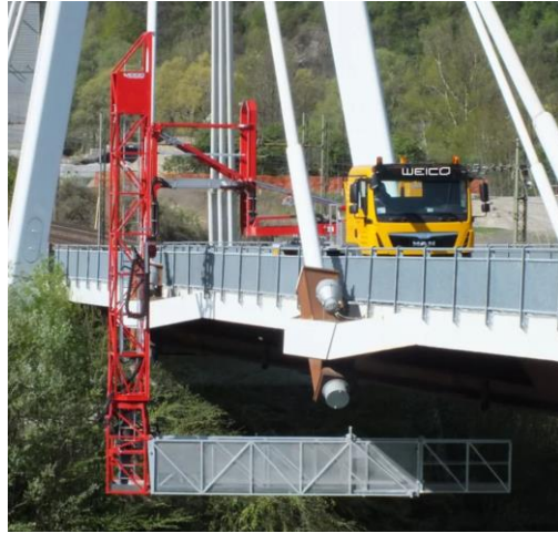
Figura 4: Accesso viadotto tramite sistema by-bridge [10].
