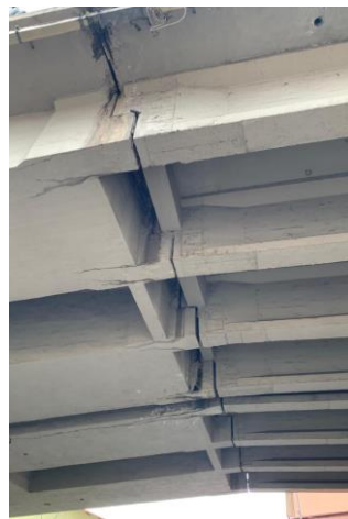
Figura 21: Esempio sella Gerber con traverso
