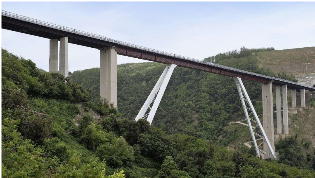
Figure 13. A2 "Autostrada del Mediterraneo" - viadotto Sfalassà
