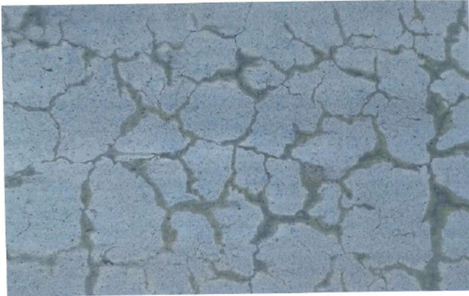
*Figura 21. Microfessurazioni da reazione alcali-aggregati*
