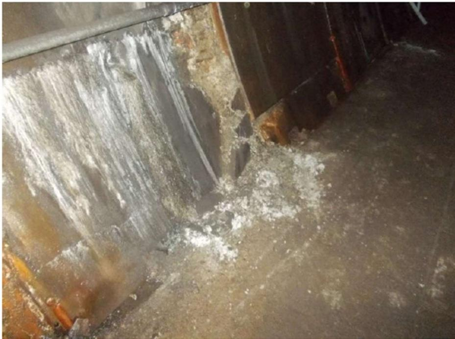
*Figura 14. Degrado da attacco solfatico in una galleria del nord Italia [15]*
