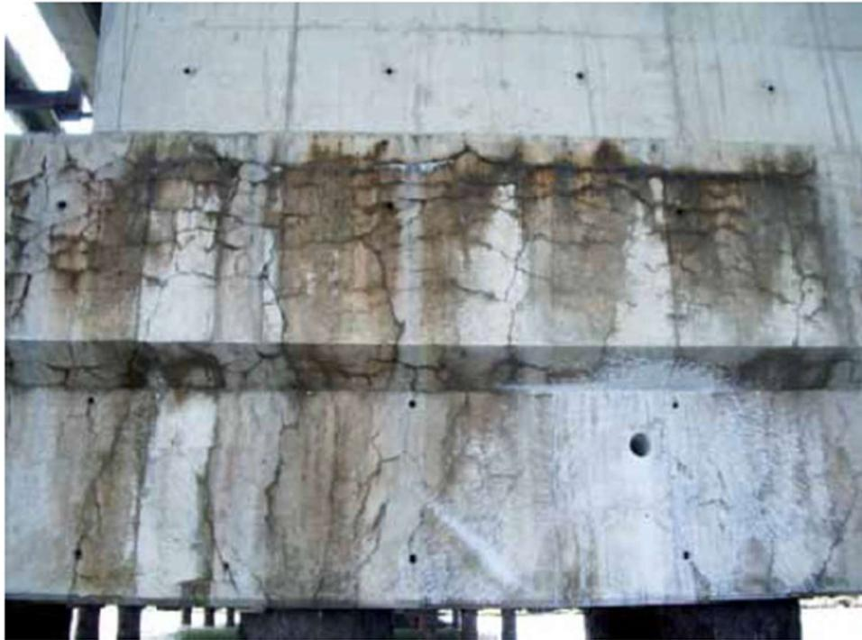
*Figura 23. Macrofessurazioni dovute alla reazione alcali-aggregati*
