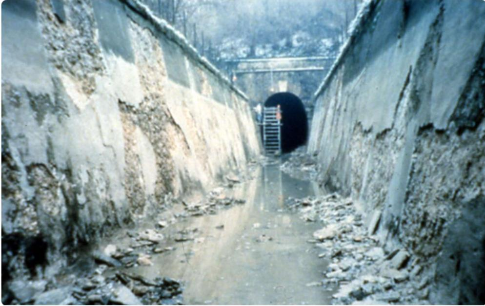
*Figura 13. Degrado causato dall'attacco solfatico in un canale in c.a. [22]*
