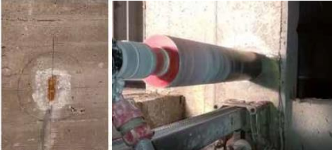
Figura 31 – Sx preparazione della superficie – Dx esecuzione prova di detensionamento [10]
