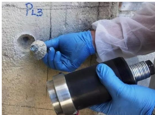
Figura 16 - Cuneo estratto dalla prova di pull out
