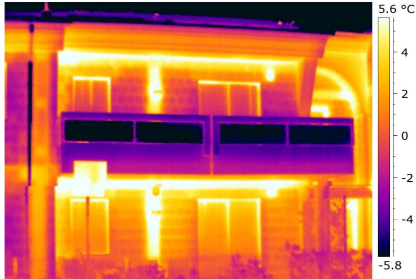
Figura 5 – La termografia mostra la dispersione termica sulle pareti [2]
