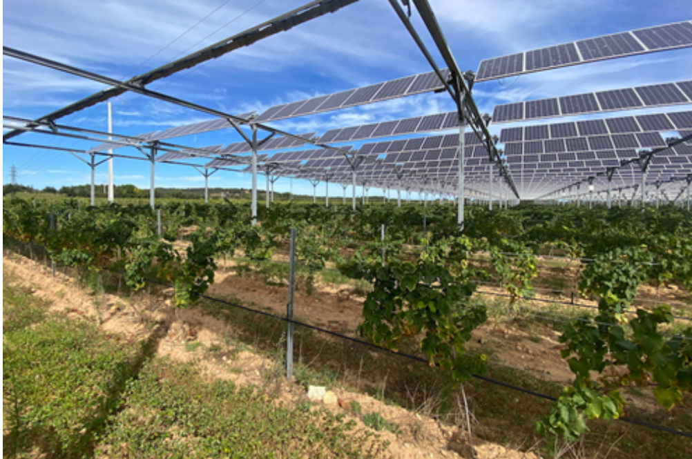
Figura 2.24: Vigneto con impianto agrivoltaico
