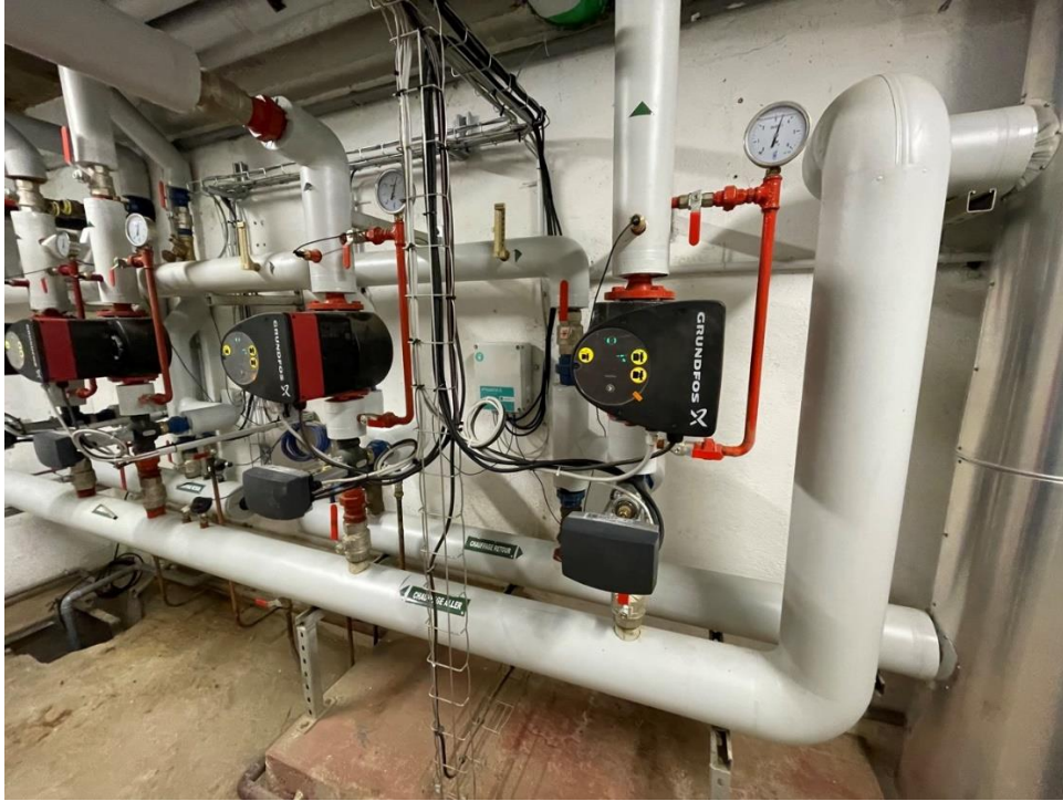
Figura 14 - Circuiti riscaldamento Bâtiment 11B
