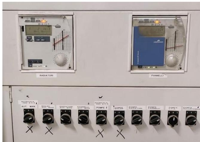
*Figura 24 - Pannello di gestione dei circuiti di riscaldamento*
