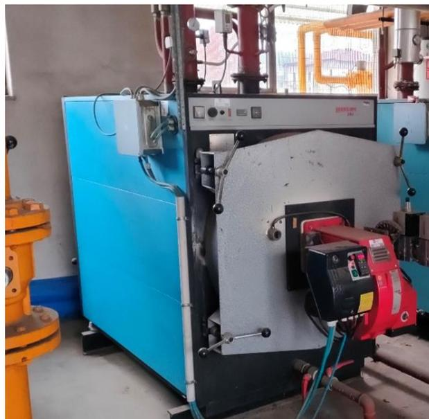
*Figura 22 - Caldaia BKLIM da 697 kW*
