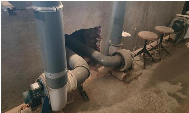
*Figura 32 - Motori di aspirazione delle cappe*
