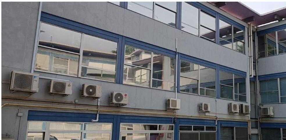
*Figura 29 - Condizionatori autonomi (tipo split) del primo piano*
